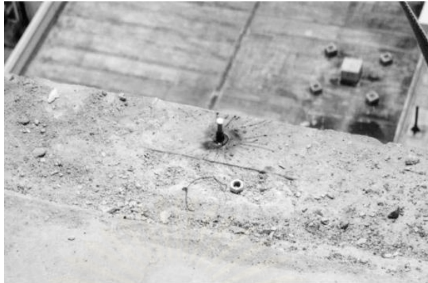
แผนภาพที่ 4.16 แสดง Stud Bolt ที่ถูกเชื่อมกับตัวอาคาร
