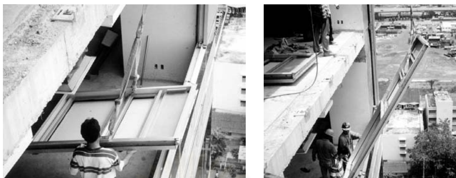
แผนภาพที่ 4.19 แสดงการยกแผง Curtain wall
