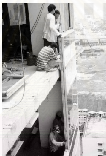
แผนภาพที่ 4.20 แสดงการนำแผงเข้าประกอบกับอุปกรณ์ยึดแผง
