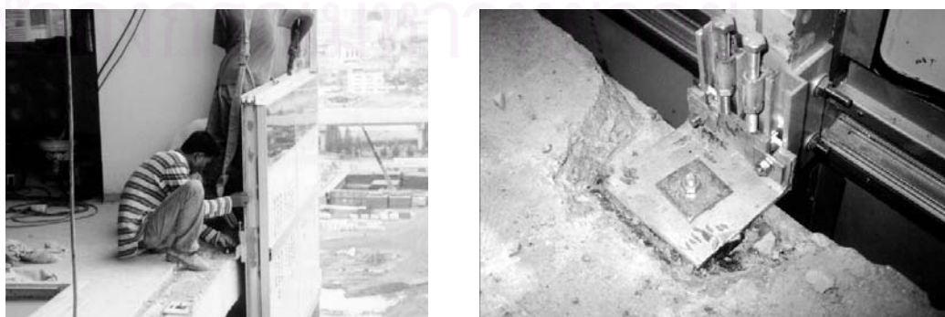
แผนภาพที่ 4.21 แสดงการใส่อุปกรณ์ยึดแผง
