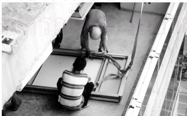
แผนภาพที่ 4.18 แสดงการผูกแผงเข้ากับอุปกรณ์ยกแผง (Hoist)
