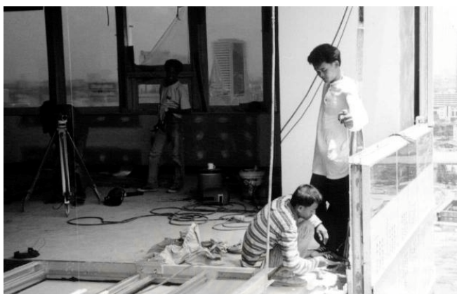
แผนภาพที่ 4.22 แสดงการวัดและปรับระดับแผงให้อยู่ในแนวเดียวกัน
