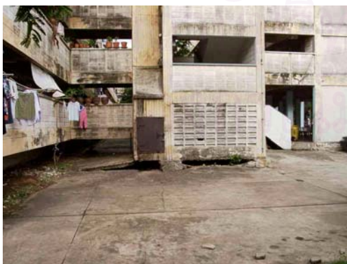
รูปภาพที่ 3.9 สภาพการทรุดตัวของพื้นถนนข้างอาคาร
