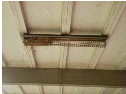
รูปภาพที่ 3.10 สภาพสัญญาณเตือนเพลิงไหม้ชำรุด และไฟฟ้าส่องสว่างมืงทำรัง
