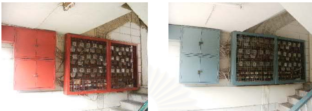
รูปภาพที่ 3.16 การปรับปรุงแผงมิเตอร์ไฟฟ้า
