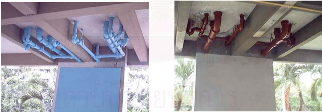
รูปภาพที่ 3.15 การปรับปรุงท่อระบายน้ำทิ้ง
