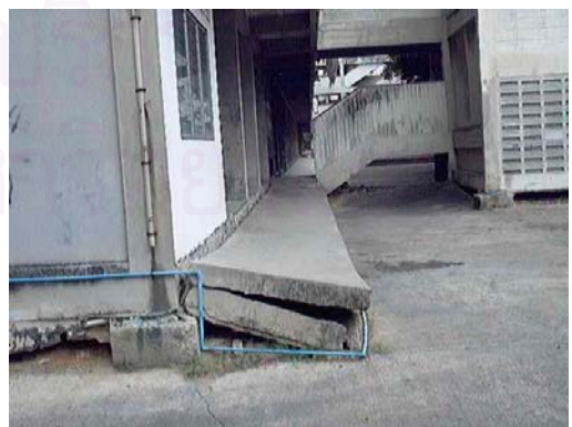
รูปภาพที่ 3.9 สภาพการทรุดตัวของพื้นถนนข้างอาคาร
