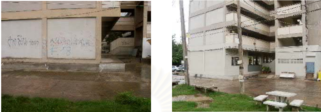
รูปภาพที่ 3.14 การการซ่อมแซมพื้นที่ด้านข้างอาคารชุดเคหะชุมชนคลองจั่น
