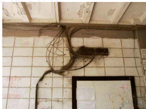
รูปภาพที่ 3.22 ปัญหาระบบไฟฟ้าภายในอาคารอยู่ในสภาพไม่เรียบร้อย
