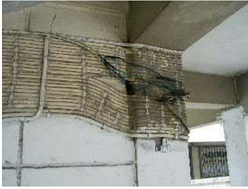
รูปภาพที่ 3.23 ปัญหาระบบไฟฟ้าภายในอาคารอยู่ในสภาพไม่เรียบร้อย
