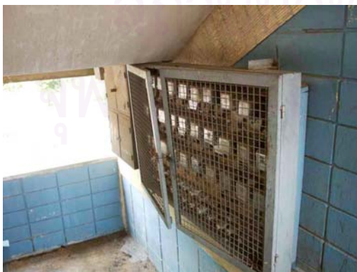
รูปภาพที่ 3.22 ปัญหาระบบไฟฟ้าภายในอาคารอยู่ในสภาพไม่เรียบร้อย
