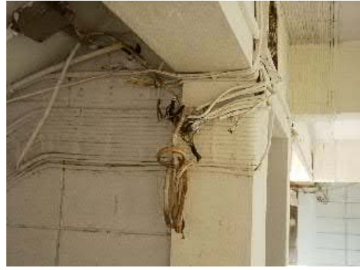
รูปภาพที่ 3.23 ปัญหาระบบไฟฟ้าภายในอาคารอยู่ในสภาพไม่เรียบร้อย
