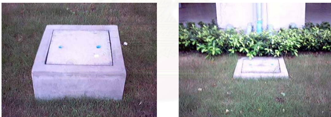
รูปภาพที่ 3.17 การปรับปรุงบ่อพักน้ำทิ้ง บ่อเกราะ
