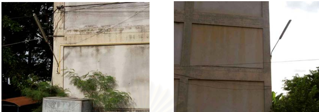
รูปภาพที่ 3.18 การติดตั้งไฟฟ้าแสงสว่าง
