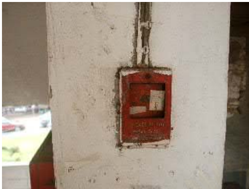
รูปภาพที่ 3.10 สภาพสัญญาณเตือนเพลิงไหม้ชำรุด และไฟฟ้าส่องสว่างมืงทำรัง
