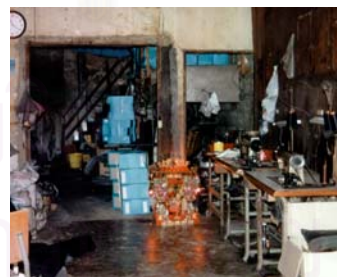
ภาพที่ 4.8 แสดงตึกแถวองค์การฟอกหนัง ที่มา: สำนักงานทรัพย์สินฯ
