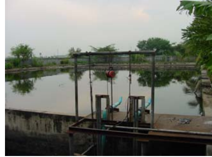
ภาพที่ 4-19 บ่อน้ำบาดน้ำเสีย
