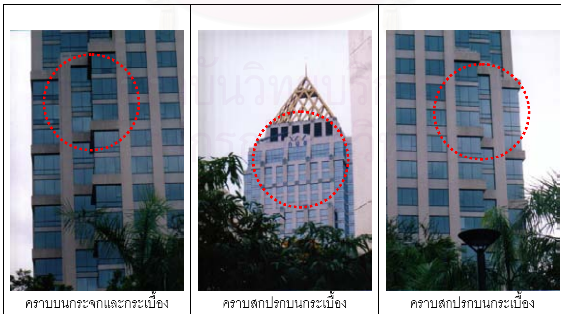
รูปภาพ 3-39 แสดงสภาพปัญหาของอาคารอับดุลราฮิม ในช่วงที่ 2
