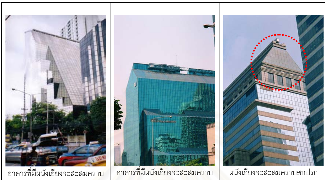
รูปภาพ 4-9 แสดงสภาพปัญหาการสะสมคราบสกปรกซึ่งมีสาเหตุจากการออกแบบรูปทรงอาคาร
