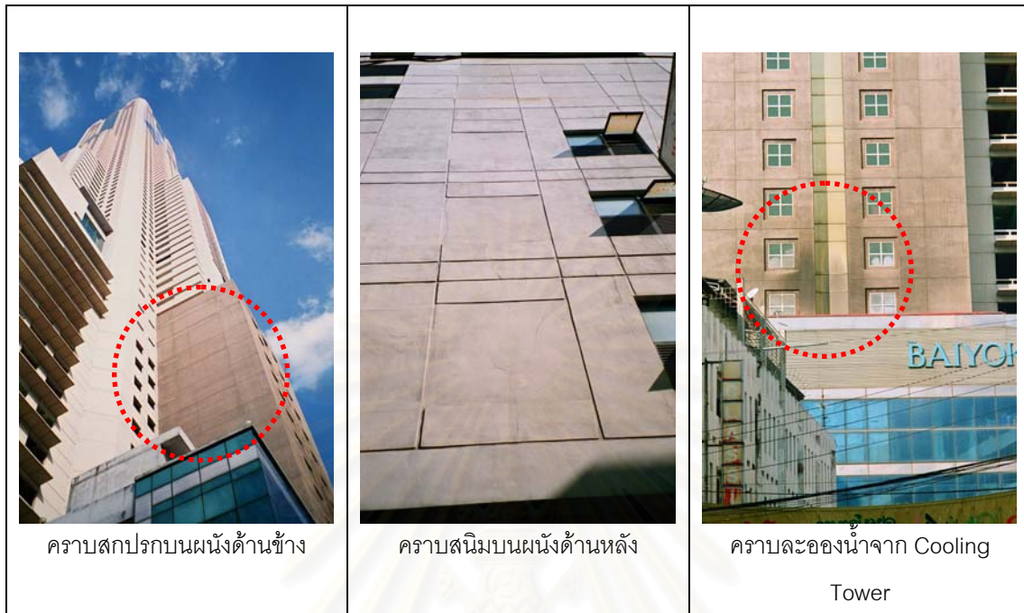
รูปภาพ 3-31 แสดงสภาพปัญหาของอาคารไบทยก 2 ในช่วงที่ 3
