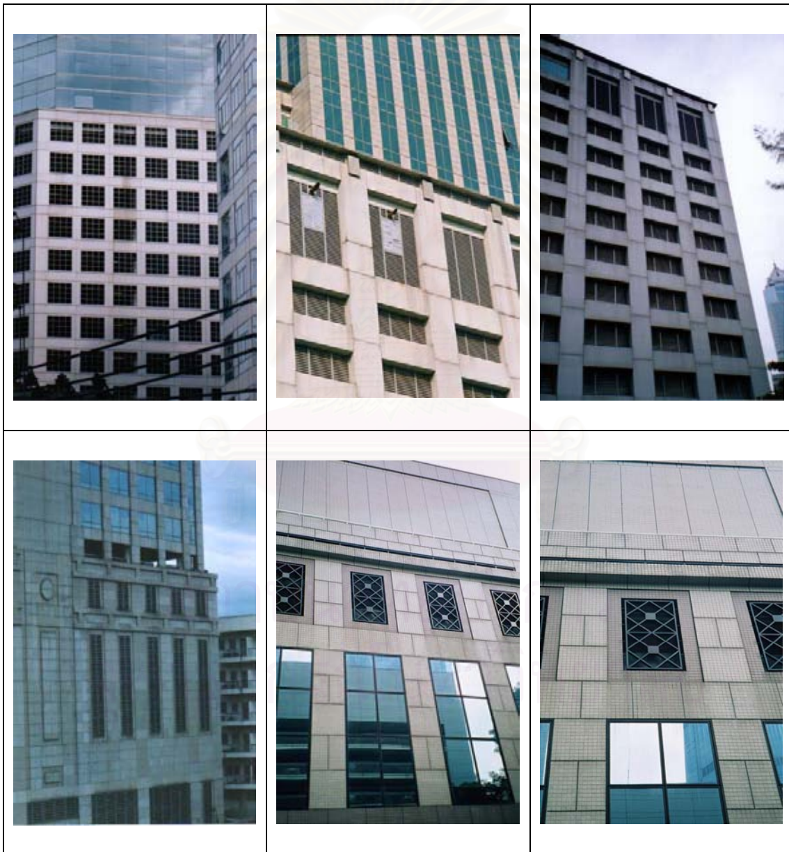
รูปภาพ 4-17 แสดงสภาพปัญหาคราบสกปรกบริเวณอาคารจอดรถซึ่งมีสาเหตุจากเขม่ารถยนต์
