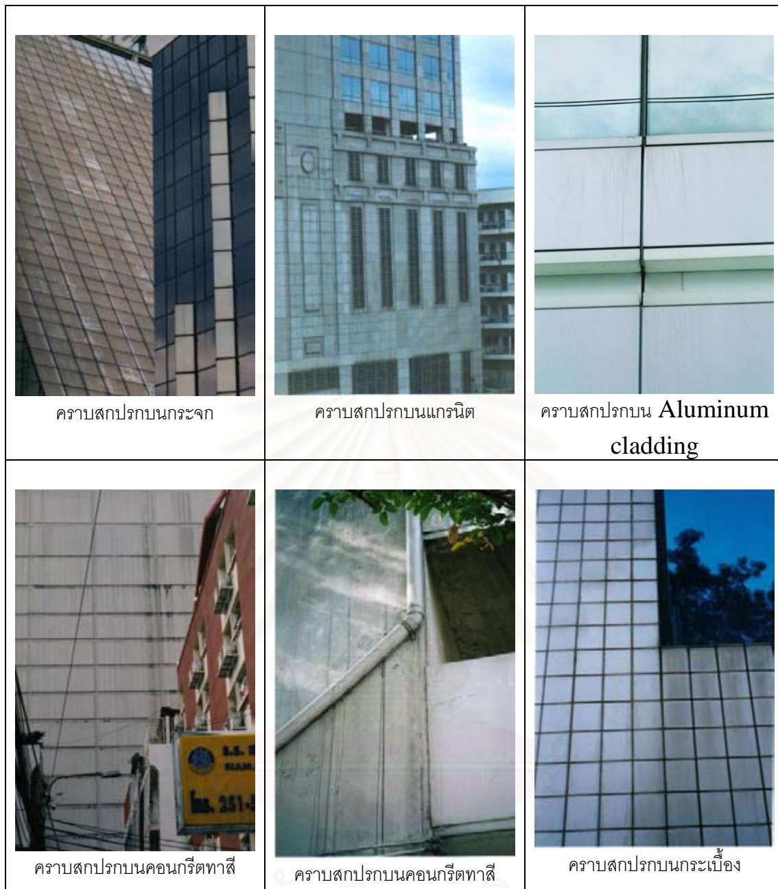
รูปภาพ 4-8 แสดงสภาพปัญหาซึ่งมีสาเหตุจากที่ตั้งและสภาพแวดล้อม
