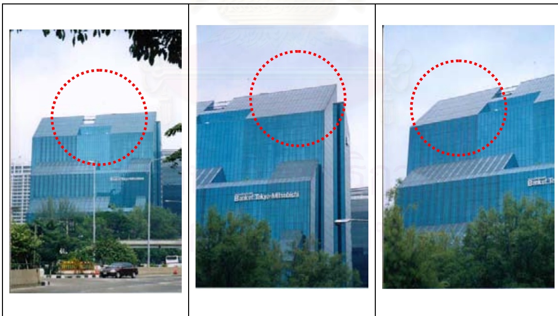
รูปภาพ 4-14 แสดงอาคารไม่มีอุปกรณ์หรือส่วนใดของอาคารเพื่อใช้ในการยึดเชือกเพื่อโรยตัว
