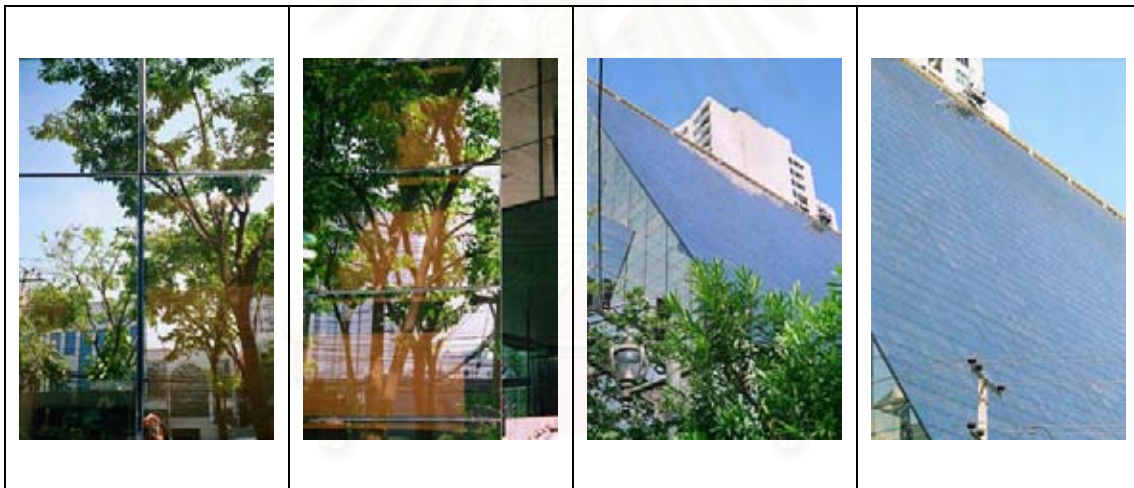
รูปภาพ 3-4 แสดงสภาพผนังภายนอกอาคารสิริวิทยุ หลังจกทำความสะอาด
