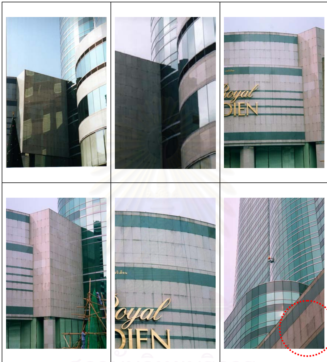
รูปภาพ 2-13 แสดง ลักษณะการ Bleeding บนผนังแกรนิต
