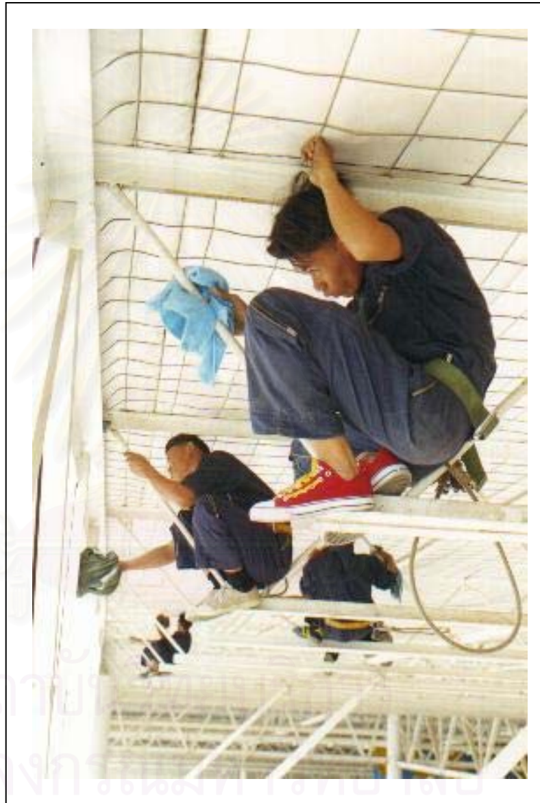
รูปภาพ 2-14 สภาพโครงสร้างอาคารซึ่งไม่เอื้อต่อการทำความสะอาด
