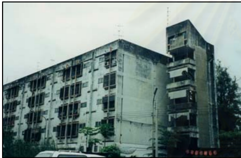
บริเวณด้านหลังของอาคารแฟลตเก่า
