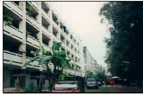
บริเวณด้านหน้าของอาคารแฟลตเก่า
