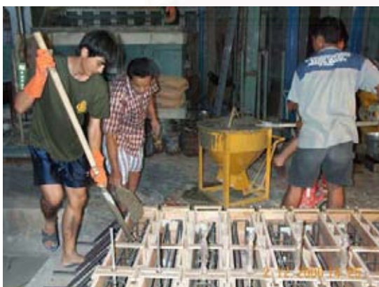
รูปที่ ข-3 ภาพการเทคอนกรีตคานชั้นแรก 10 ซม.
