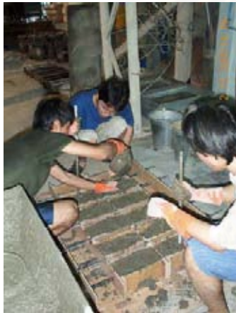
รูปที่ ข-7 ภาพการเทคอนกรีตและกระทุ้งตัวอย่างที่ใช้ในการทดสอบกำลังยึดเหนี่ยวระหว่างคอนกรีตกับเหล็กเสริม
