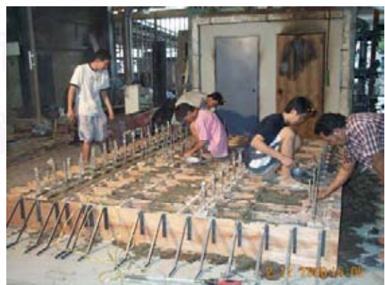
รูปที่ ข-10 ภาพการติดตั้งเดือยเหล็ก
