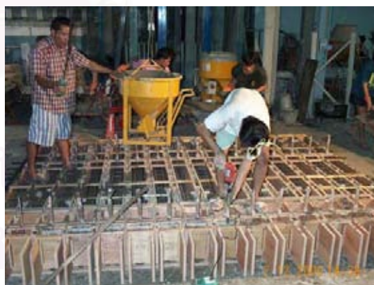
รูปที่ ข-4 ภาพการจี้คอนกรีตภายในคานชั้นแรก
