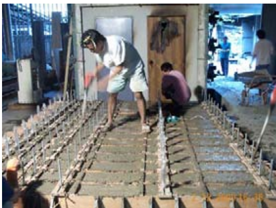
รูปที่ ข-11 ภาพการเทและจัดคอนกรีตชั้นสุดท้าย
