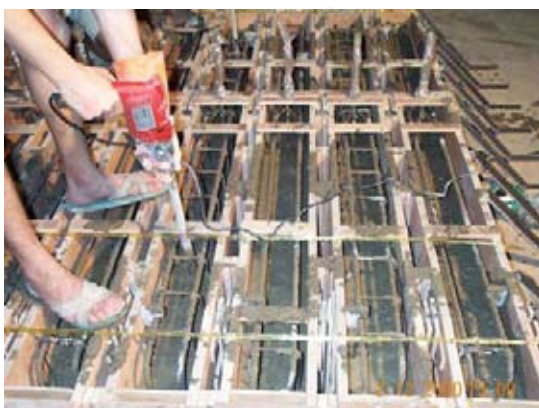
รูปที่ ข-9 ภาพการเทและจี้คอนกรีตที่เทชั้นที่สอง
