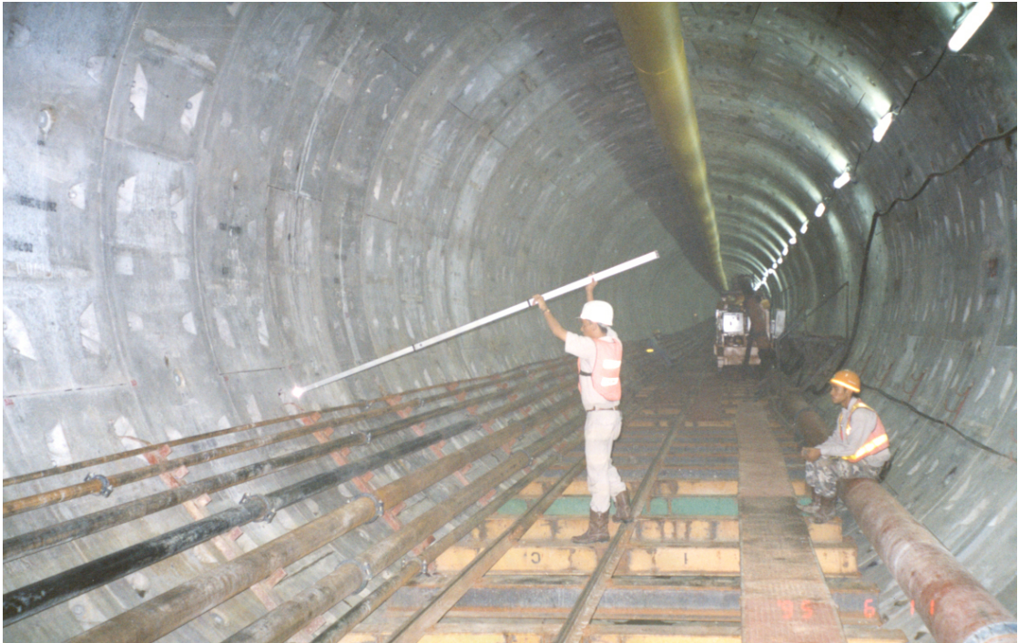
รูปที่ 3.2 แสดงการวัดค่าพิกัดภายในอุโมงค์ 8 ตำแหน่ง
