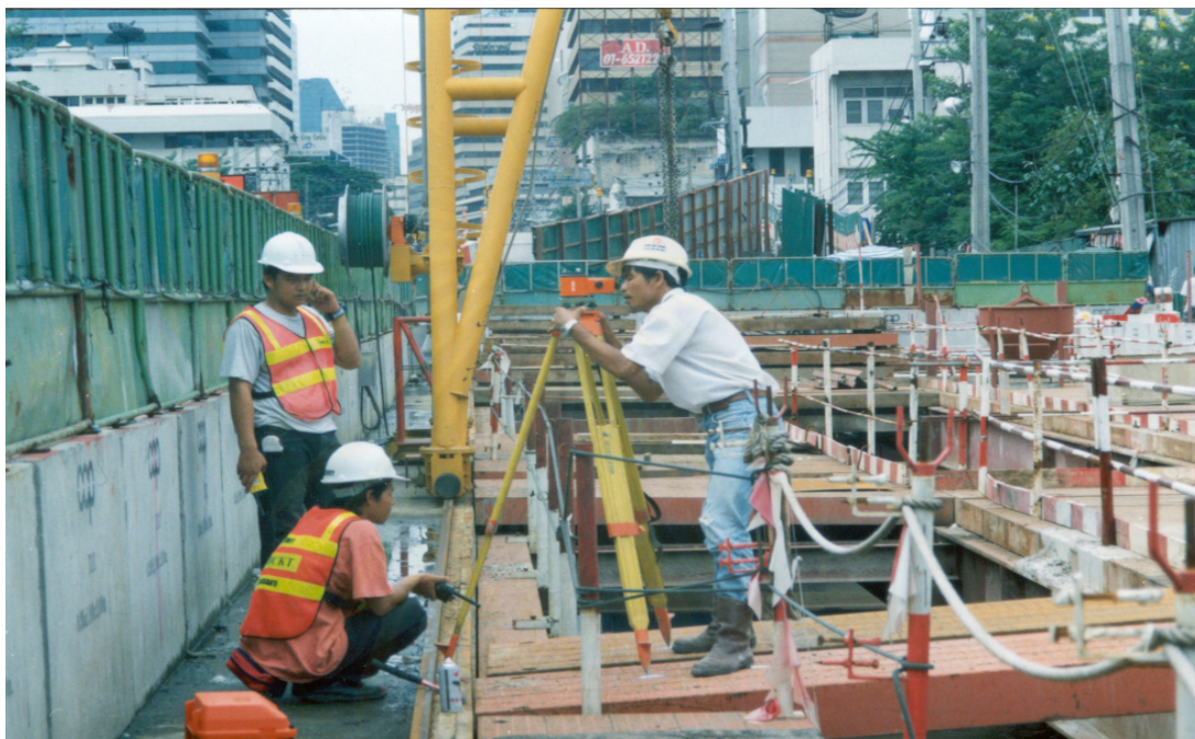
รูปที่ 2.4 แสดงการถ่ายค่าพิกัดฉากในภาคสนาม
