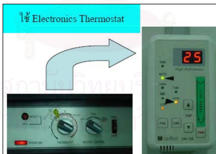
รูปที่ 5.19 เปลี่ยนเทอร์โมสแตทเป็นแบบอิเล็กทรอนิกส์
