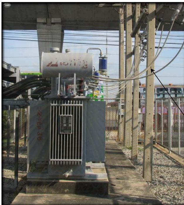
รูปที่ 5.6 สายไฟฟ้าแรงสูงที่จ่ายเข้าหม้อแปลง
