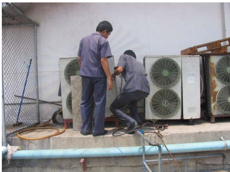
รูปที่ 5.20 ทำการเปลี่ยนอุปกรณ์เครื่องปรับอากาศ
