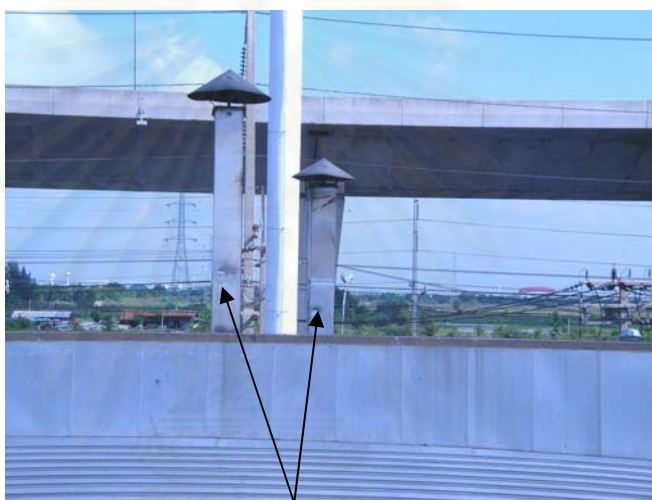
รอยเจาะปล่องระบายความร้อน
