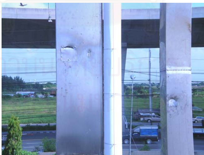
รูปที่ 4.3 ทำการเจาะรูปล่องระบายความร้อนเพื่อหาค่าปริมาณ \text{O}_2 และ \text{CO}
