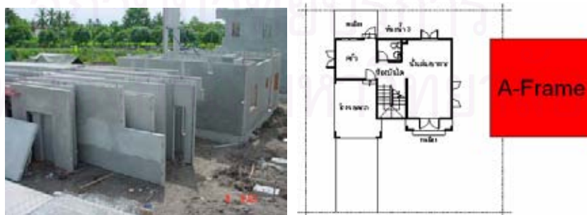
รูปที่ 5.19 แสดงพื้นที่ในการกอบเก็บวัสดุ
