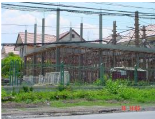
รูปที่ 1.3 แสดงการก่อสร้างระบบหล่อในที่
