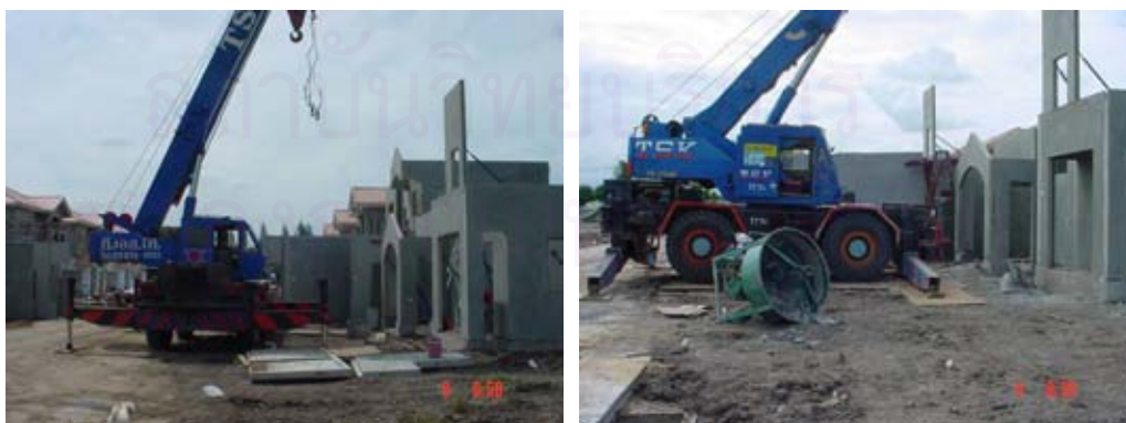
รูปที่ 4.3 แสดงการตั้งรถเครนแบบขนานกับตัวบ้าน (ซ้าย) และตั้งฉากกับตัวบ้าน (ขวา)
