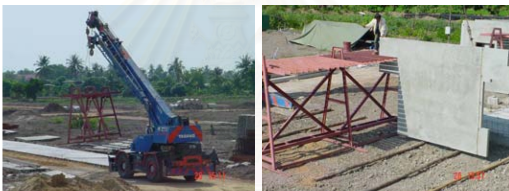
รูปที่ 4.6 แสดงการเตรียมพื้นที่ และอุปกรณ์ในการกองเก็บ
