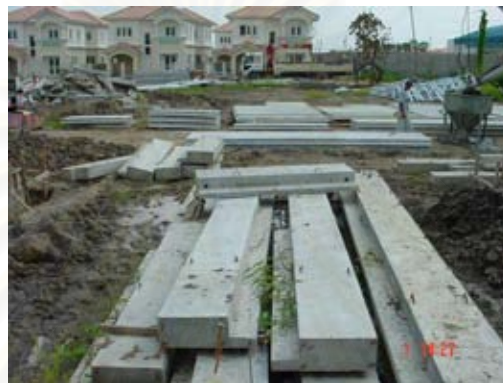
รูปที่ 4.13 แสดงการกองเก็บชิ้นส่วนคอนกรีตสำเร็จรูป
