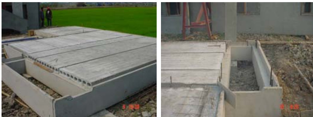
รูปที่ 4.7 แสดงปัญหาความไม่ครบถ้วนของชิ้นส่วนคอนกรีตสำเร็จรูป
