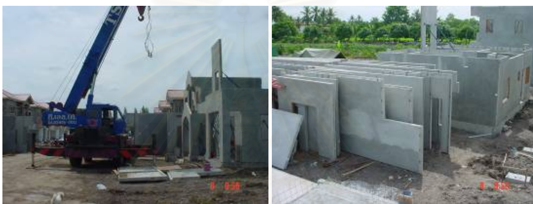
รูปที่ 1.4 แสดงการใช้พื้นที่ในการทำงานของการก่อสร้างระบบชั้นส่วนสำเร็จรูป
