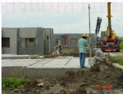
รูปที่ 4.8 แสดงการสำรวจระดับก่อนการติดตั้งชิ้นส่วนผนังคอนกรีตสำเร็จรูป
