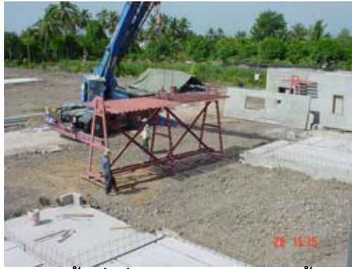
รูปที่ 4.12 แสดงการเตรียมพื้นที่เพื่อใช้ในการกองเก็บชิ้นส่วนคอนกรีตสำเร็จรูป
