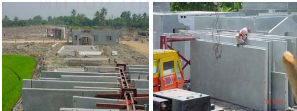
รูปที่ 4.5 แสดงการกองเก็บชิ้นส่วนคอนกรีตสำเร็จรูป
