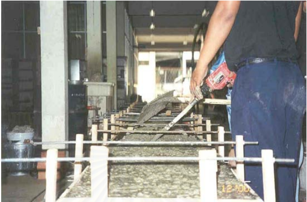
รูปที่ 3.32 การเทคอนกรีตทับหน้า
