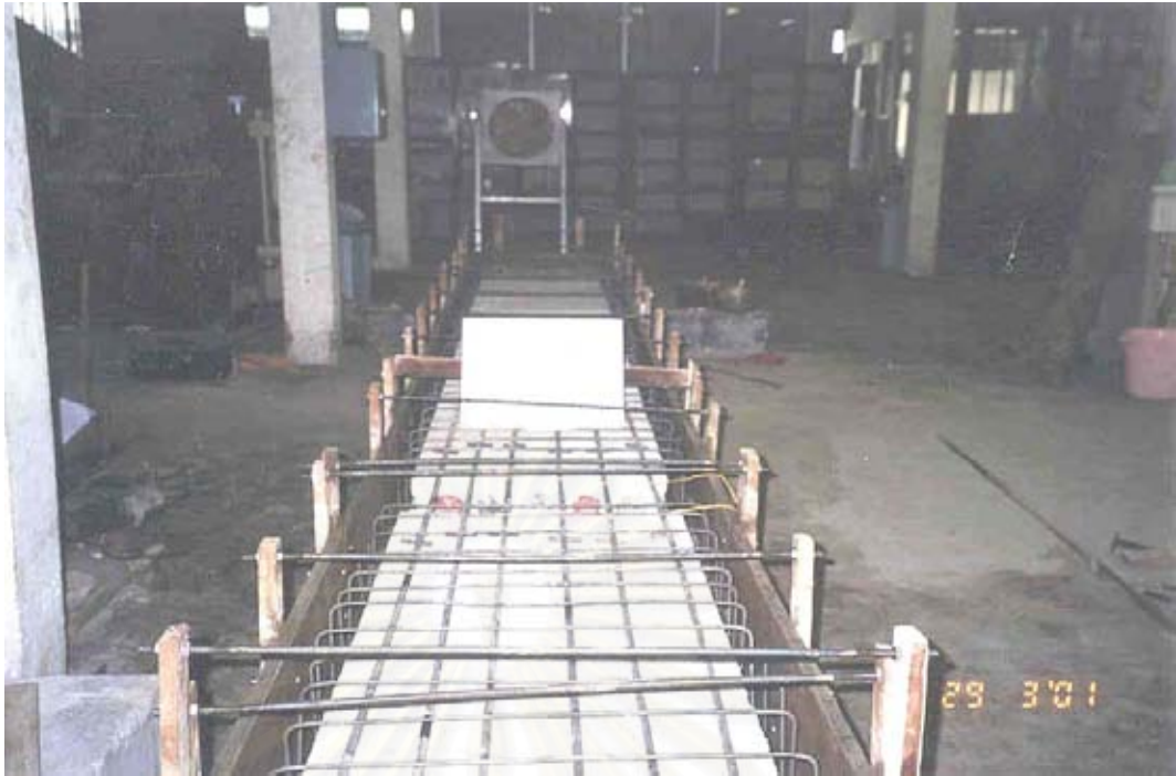
รูปที่ 3.30 การเข้าแบบตัวอย่างทดสอบ ก่อนเทคอนกรีตเททับหน้า
