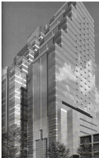
ภาพที่ 47 แสดงอาคาร ITF และ SSP Tower สวรร
