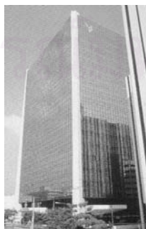
ภาพที่ 17 แสดงธนาคารกสิกรไทย (สำนักงานใหญ่เก่า) พหลโยธิน ออกแบบโดย รั้งสรรพค์ ต่อสุวรรณ ที่มา: จากหนังสือ “สถาปนิกสยาม พื้นฐาน บทบาท ผลงานและแนวคิด (พ.ศ. 2475- 2537)” (2539)
