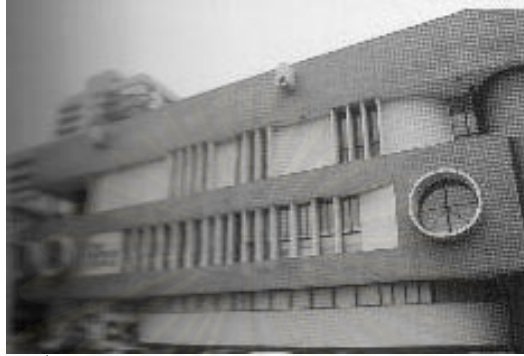
ภาพที่ 26 แสดงอาคารบริติช เคาน์ซิล (เก่า) ออกแบบโดย สุเมธ ชุมสาย ณ อยุธยา ที่มา: จากหนังสือ “สถาปนิกสยาม พื้นฐาน บทบาท ผลงานและแนวคิด (พ.ศ. 2475- 2537)” (2539)
