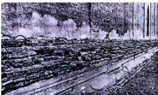
ภาพที่ 64 แสดงส่วนที่เสียหายจากความชื้นที่มีผล
