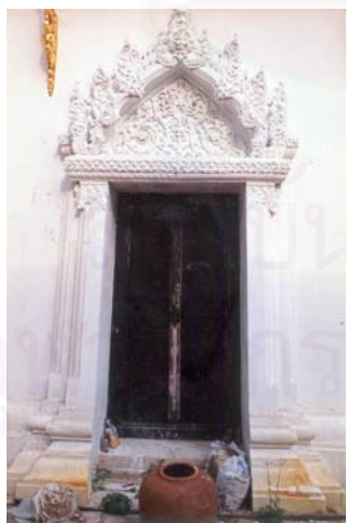
ภาพที่ 192 ลักษณะประตูด้านข้างวัดกลาง จ.สมุทรปราการ (ทรงบันแถลง)
