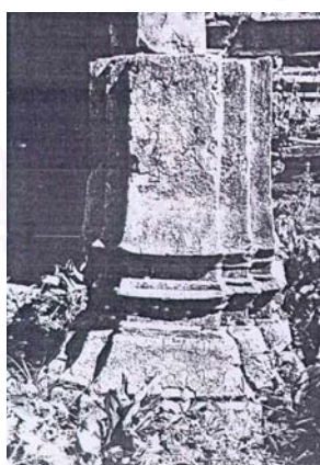
ภาพที่ 104 เเทงเสาของเสาสี่เหลี่ยมย่อมุม 12 วัดไชยวัฒนาราม (เสาระเบียงคด)
