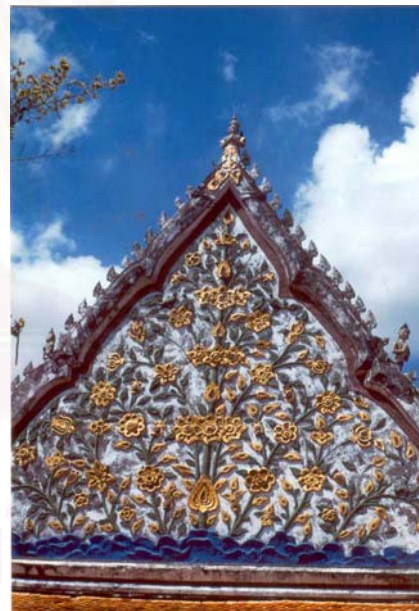
ภาพที่ 240 ลักษณะเครื่องลำยอง ปูนปั้นลวดลาย อย่างเทศวัดทองศาลางาม จ.กรุงเทพฯ
