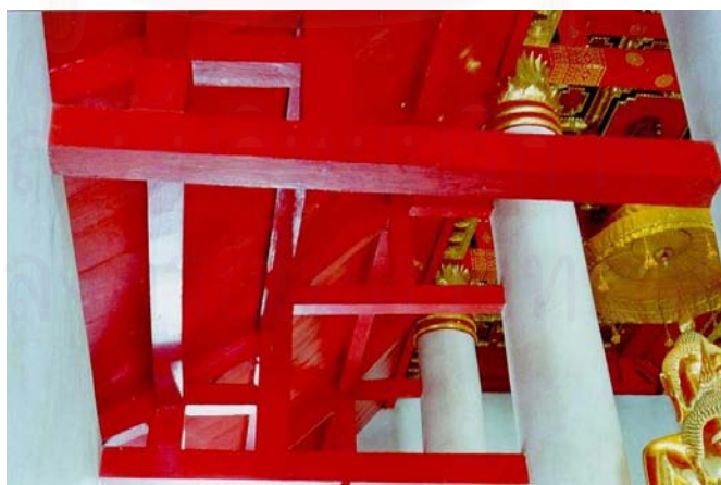
ภาพที่ 69 ลักษณะโครงสร้างหลังคาเครื่องประดู่แบบมีไม้ยึดโครง วัดกษัตราธิราช
