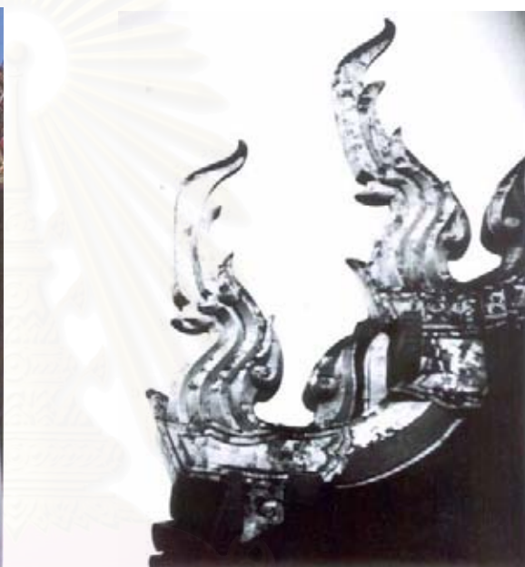
ภาพที่ 147 ขยายหางหงส์ (สภาพหลังการบูรณะ ซ่อมแซม)
