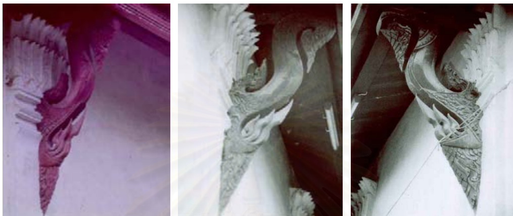
ภาพที่ 107 คันทวยรูปแบบต่างๆ ที่ปรากฏอยู่ที่พระอุโบสถวัดปราสาท จังหวัดนนทบุรี
