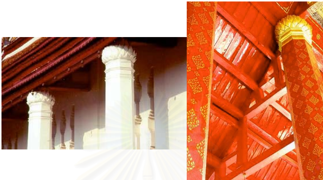
ภาพที่ 9 ลักษณะเสาและบัวหัวเสานางเรียง (รูปซ้าย) และเสาร่วมในประธาน (รูปขวา) พระอุโบสถวัดหน้าพระเมรุ
