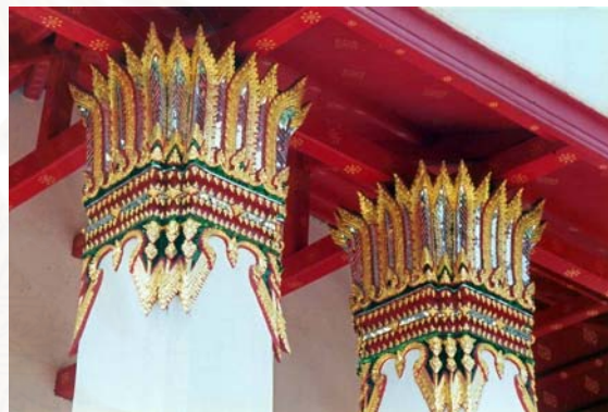
ภาพที่ 181 ขยายรายละเอียดบัวหัวเสาแบบบัวจกกล หรือบัวแวง
