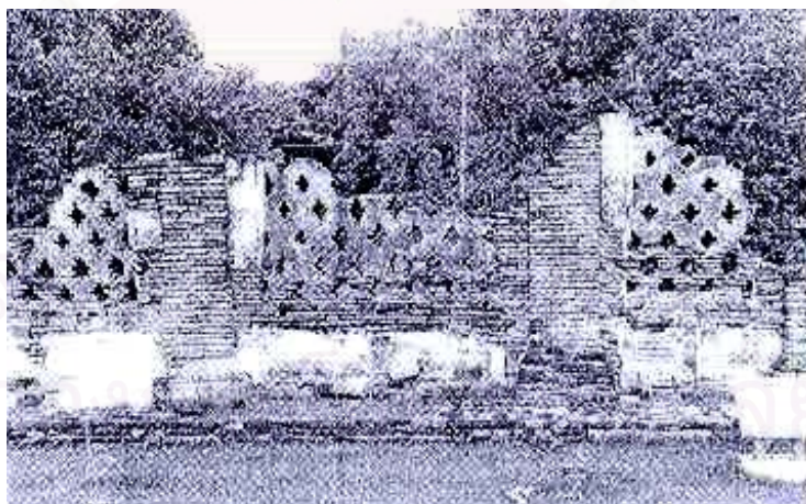
ภาพที่ 43 ซากกำแพง และลักษณะของช่องแสงของวิหารแถบด้านหลังของวัดพระศรีสรรเพชญ์ เป็นลักษณะการเจาะช่องแสงอีกลักษณะหนึ่ง ซึ่งน่าจะมีความเชื่อมโยงกับลักษณะการทำช่องแสงในยุคต้นเช่นกัน โดยเป็นช่องเจาะสี่เหลี่ยมขนมเปียกปูน ลักษณะย่อมุมหรือที่เรียกกันว่า “ผนังลับแล”
