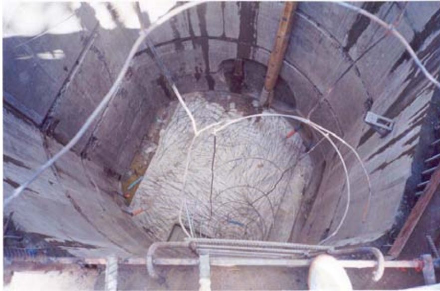
รูปที่ 1.3 บ่อรับ (Receive Pit)
