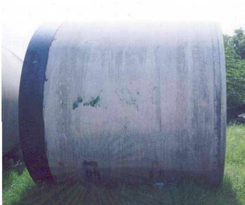
รูปที่ 1.5 ด้านข้างท่อคอนกรีต
