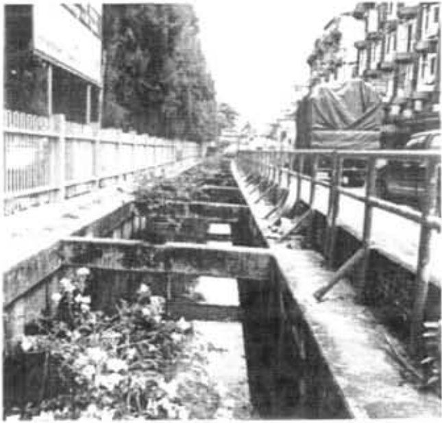
คูย่อยคอนกรีต
