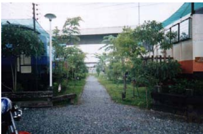
ภาพที่ 4.68 สภาพถนนและไฟฟ้าส่องสว่างในโครงการ
