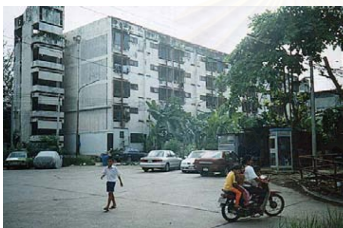
ภาพที่ 4.33 สภาพด้านหน้าอาคารแฟลต 4
