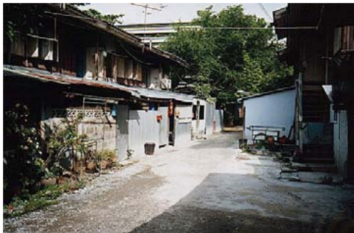
ภาพที่ 4.15 การต่อเติมด้านหน้าอาคาร
