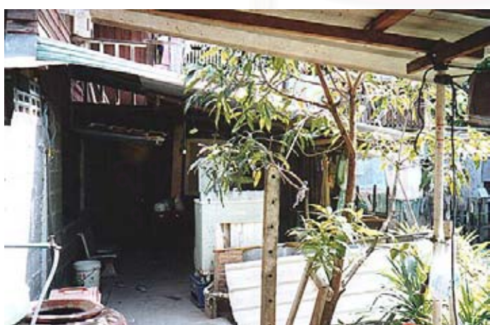
ภาพที่ 4.14 การต่อเติมด้านหลังอาคาร
