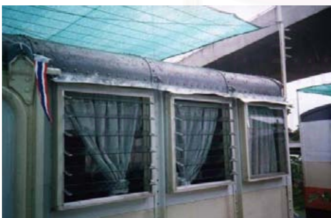
ภาพที่ 4.70 การแก้ปัญหาจากความร้อนและการไหลซึมของน้ำฝน
