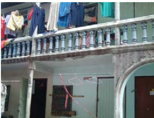
สภาพภายนอกอาคาร
