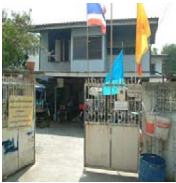
สภาพบริเวณอาคาร
