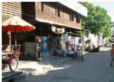
สภาพด้านหน้าอาคาร
