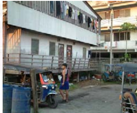
สภาพบริเวณอาคาร
