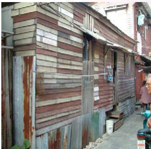
สภาพด้านหน้าอาคาร
