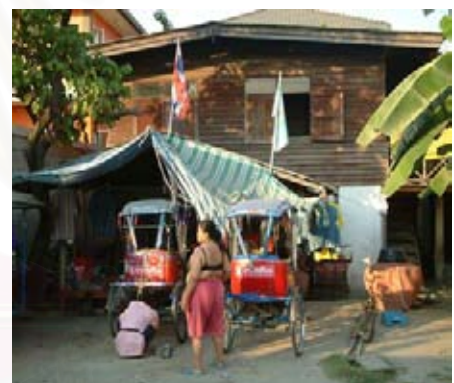
สภาพด้านหน้าอาคาร
