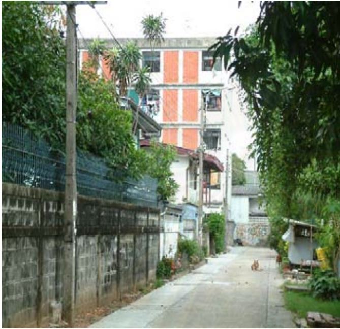
สภาพด้านหน้าอาคาร
