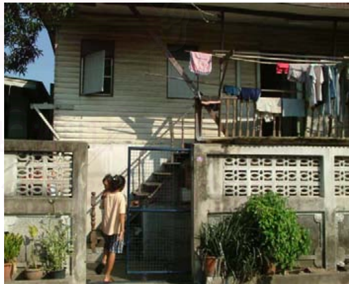
สภาพด้านหน้าอาคาร
