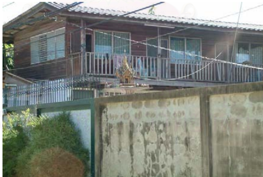
สภาพด้านหน้าอาคาร
