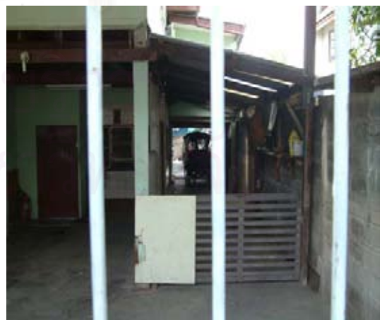
สภาพบริเวณภายในบ้าน
