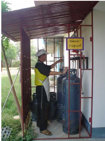
รูปที่ 4.23 แสดงภาพภายในส่วนงานโรงครัว
