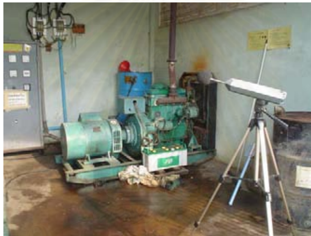
รูปที่ 4.24 แสดงภาพภายในส่วนงานซ่อมบำรุง
