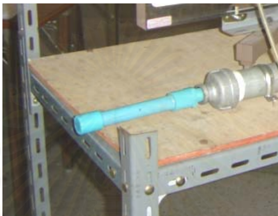
รูปที่ 4.32 แสดงวิธีการติดตั้งตำแหน่งที่เกิดการรั่วซึมกับแท่นจับยึด
