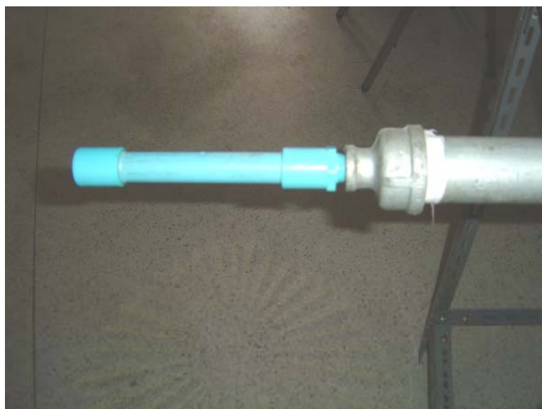
รูปที่ 4.43 แสดงวิธีการติดตั้งส่วนที่เกิดการรั่วซึม
