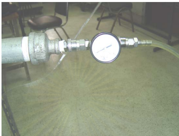
รูปที่ 4.40 แสดงการต่อท่อเหล็กกับท่อจ่ายลม
