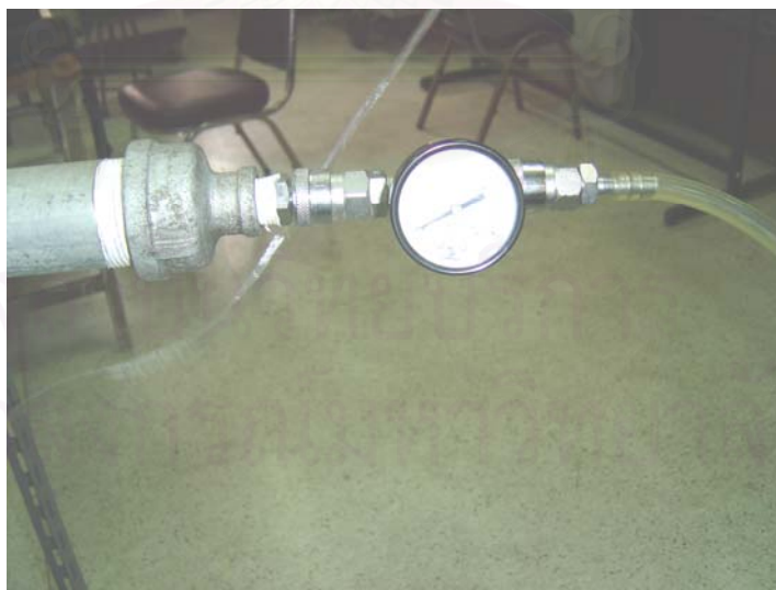
รูปที่ 4.49 แสดงการต่อท่อเหล็กกับท่อจ่ายลม
