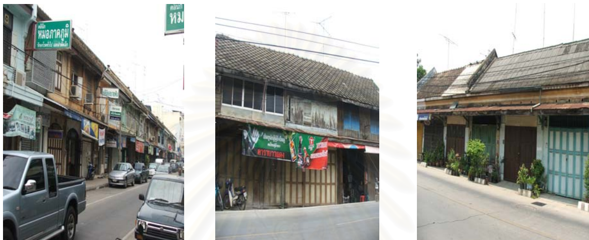
ภาพที่ 4.5 สภาพอาคารเก่าภายในเขตเทศบาลเมืองฉะเชิงเทรา
