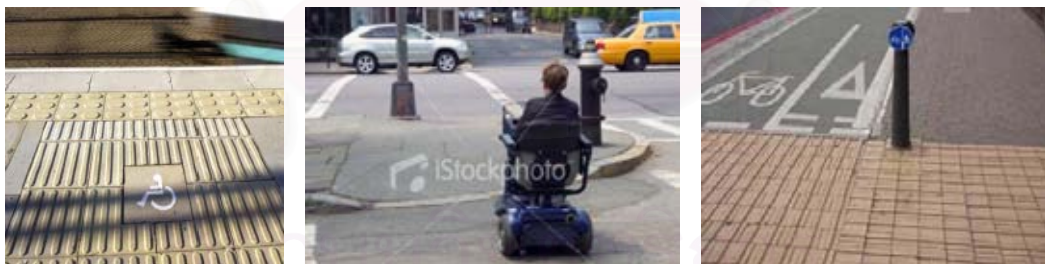
แผ่นพื้นสัญลักษณ์และการทำทางลาดสำหรับสำหรับผู้สูงอายุและผู้บกพร่องทางการเคลื่อนที่
