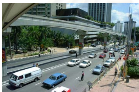
ภาพที่ 3.34 ตัวอย่างรูปแบบระบบโครงสร้างระบบราง ตัวรถไฟฟ้า และสถานี ของโครงการรถไฟฟ้าสายสีเขียว (ในส่วนที่ยกระดับขึ้นเหนือพื้นถนน) (ที่มา : http://www.kuala-lumpur-monorail.com )
