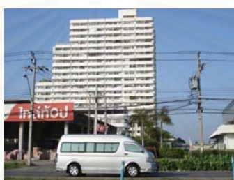
อาคารชุดพักอาศัย
