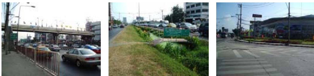
สะพานลอยข้ามถนน
