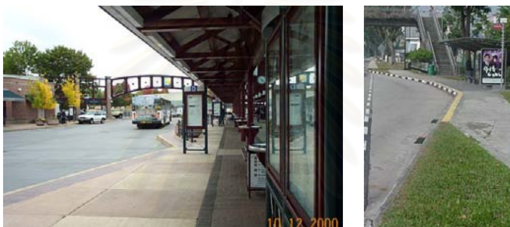
ภาพที่ 5.8 ตัวอย่างจุดจอดรถโดยสารประจำทางและจุดรถบริการที่ทำทางเบียงเข้ามาพื้นที่ทางเท้า (ที่มา : http://www.lta.gov.sg )
