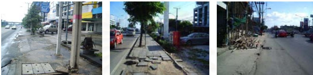
ภาพที่ 3.22 ความไม่เรียบของพื้นที่ทางเท้าถนนศรีนครินทร์ช่วงที่ทำการศึกษา
