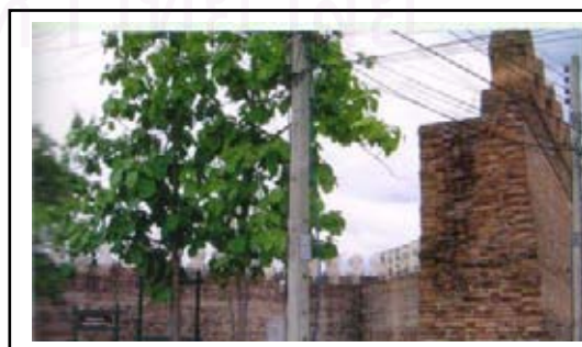
รูปที่ 4.6 ป้อมชนะสงคราม
