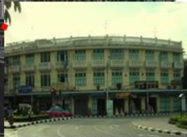
ตึกแถวถนนบำรุงเมือง เป็นอาคาร สถาปัตยกรรมลิ่งค์โปริร์ตสร้างขึ้นในสมัย รัชกาลที่ 5
