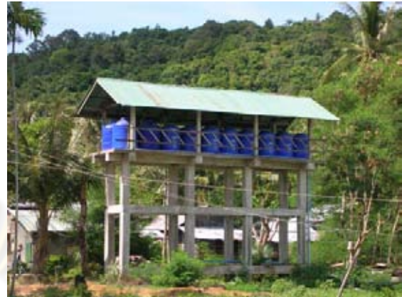
ภาพที่ 4.2 ถังเก็บน้ำจืดสำหรับโรงแรมบนเกาะพีพี ดอน
