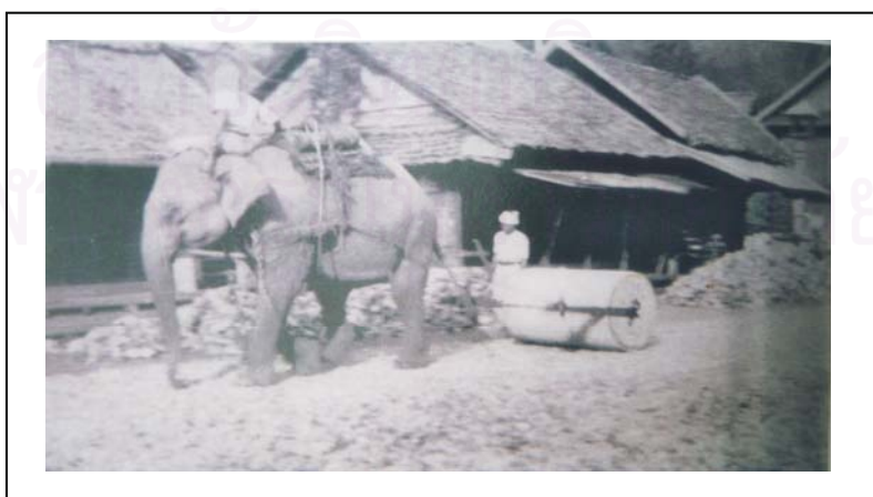
ภาพที่ 5.7 ช้างกำลังบดอัดลูกรังบนถนนสิงหนาทบำรุง ยุคสร้างเมือง (พ.ศ. 2374-2497)
