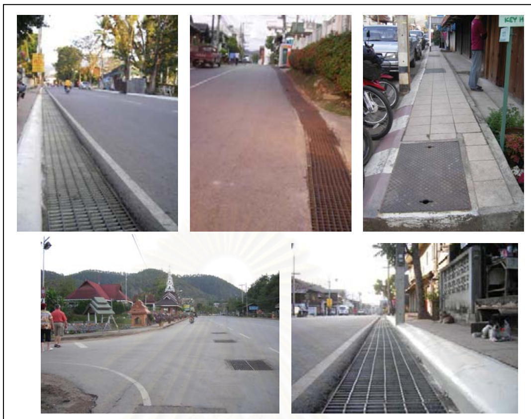
ภาพที่ 5.16 ท่อระบายน้ำที่ ปรับปรุงและวางแนวตามร่องน้ำเดิมของเมืองแม่ฮ่องสอน ยุคเปิดเมืองสู่การท่องเที่ยว พ.ศ. 2525-ปัจจุบัน
