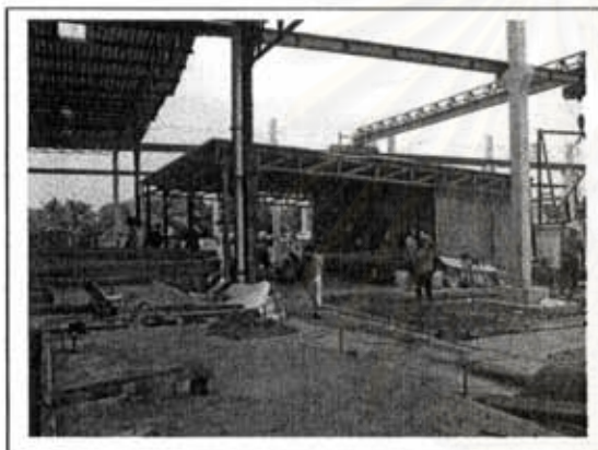
ภาพที่ 5.4 แสดงสไตร์เก็บของและโรงผูกเหล็ก
