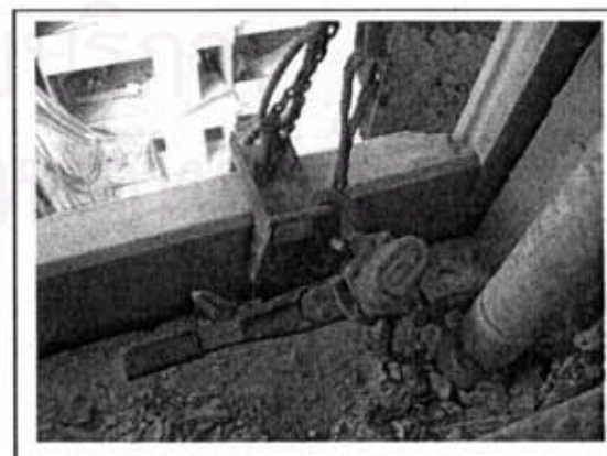
ภาพที่ 5.82 แสดงรอกตั้ง สำหรับใช้ปรับระดับแนวนอน
