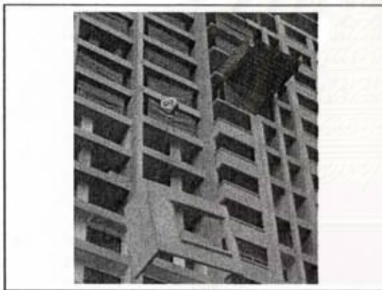
ภาพที่ 5.58 แสดงการยกชิ้นงานขึ้นเตรียมติดตั้งด้วยทาวเวอร์เครน
