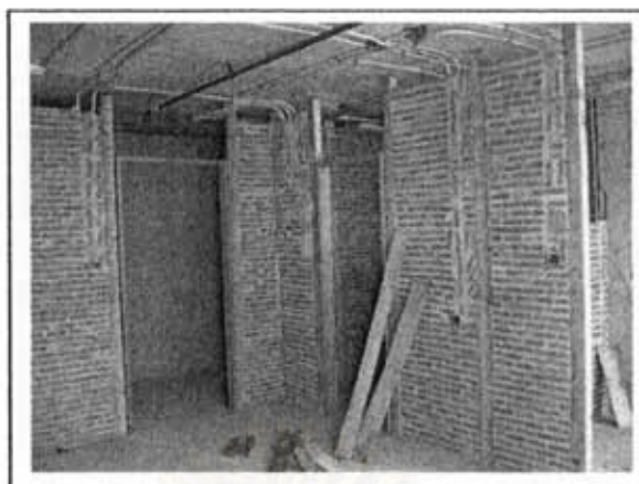
ภาพที่ 5.73 แสดงการก่อฉาบผนังภายในอาคาร
