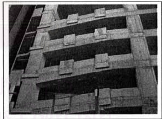
ภาพที่ 5.77 แสดงลักษณะงาน โครงสร้างที่เตรียมสำหรับ งานติดตั้ง ชิ้นส่วนผนัง ค.ส.ล. สำเร็จรูป
