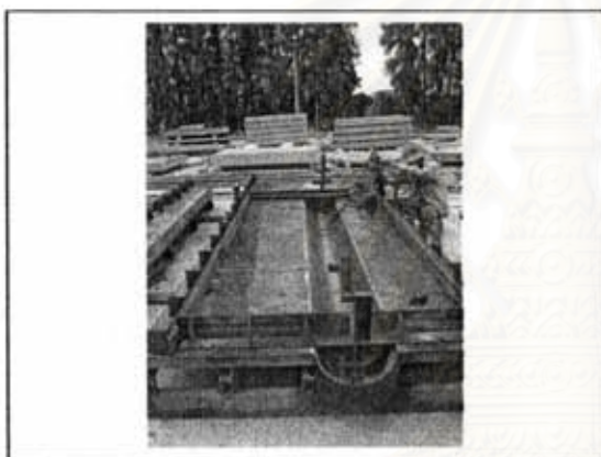
ภาพที่ 5.32 แสดงลักษณะการวางแบบหล่อ
