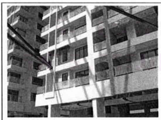
ภาพที่ 5.74 แสดงภาพภายนอกอาคาร
