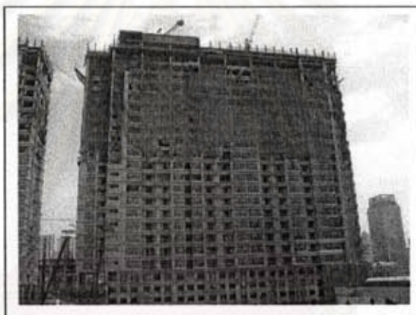
ภาพที่ 5.92 แสดงภาพภายนอกอาคาร
