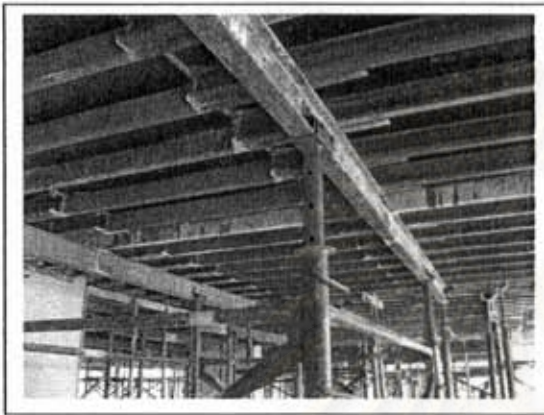
ภาพที่ 5.51 แสดงการตั้งแบบหล่อและค้ำยัน
