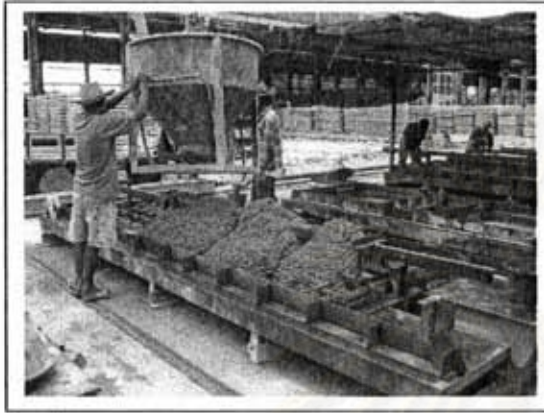
ภาพที่ 5.40 แสดงการใช้ PORTAL CRANES ในการขนส่ง BUCKET เพื่อเทคอนกรีตลงแบบหล่อ
