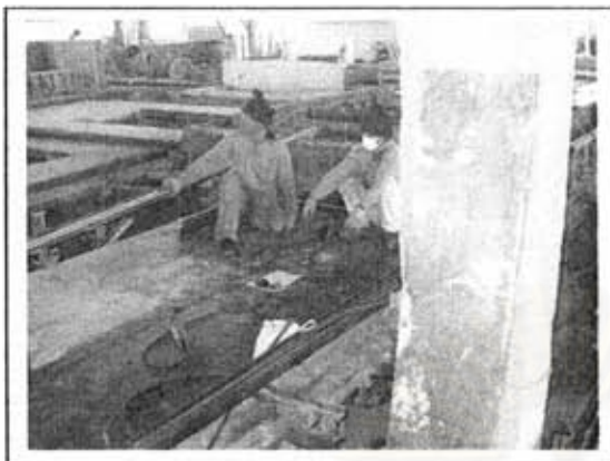
ภาพที่ 5.11 การเตรียมประกอบแบบข้าง
