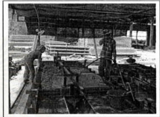
ภาพที่ 5.41 แสดงการจี้คอนกรีต โดยเครื่องจักรไฟฟ้า
