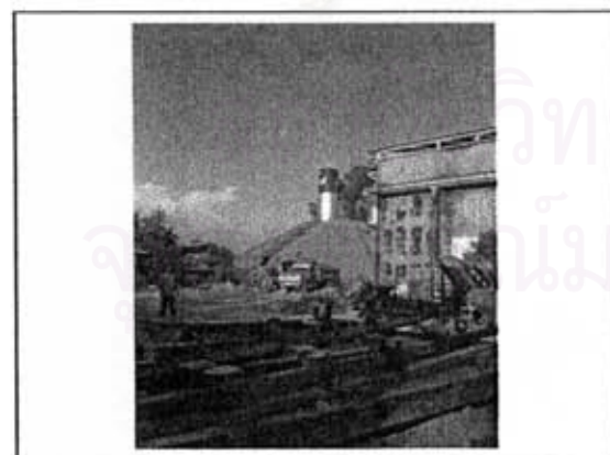
ภาพที่ 5.26 แสดงบริเวณผสมคอนกรีต
