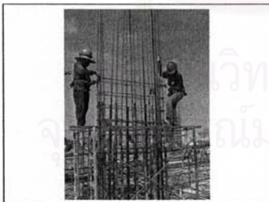
ภาพที่ 5.49 แสดงการผูกเหล็กงานเสา ค.ส.ล.
