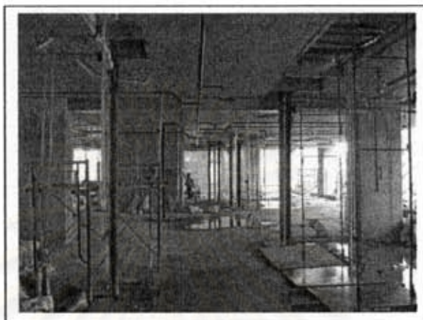
ภาพที่ 5.90 แสดงการติดตั้งงานระบบภายในอาคาร
