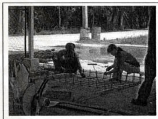
ภาพที่ 5.33 แสดงการฉุกละหุกเหล็ก
