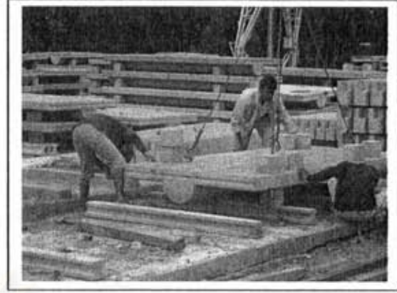
ภาพที่ 5.44 แสดงการยกชิ้นส่วนสำเร็จรูป ด้วย PORTAL CRANES
