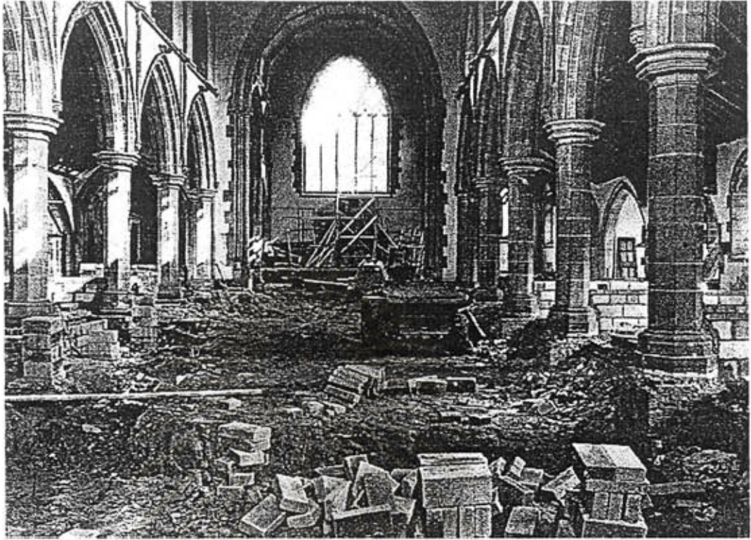
รูปแสดงการปรับปรุง St. Luke's Church โดยการใช้โครงสร้างเดิม และเพิ่มเติมโครงสร้างใหม่เข้าไปแทน ที่มา...David Highfield, Rehabilitation and Re-use of Old Buildings(London, E.&F.N. Spon.), p.168.
