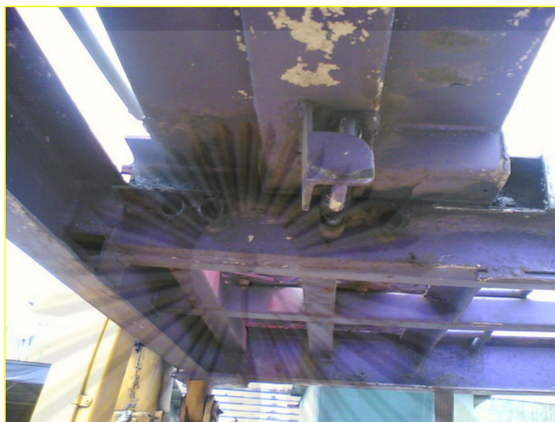
รูปที่ 4.1 แสดงอุปกรณ์ล้อคสะพานสไลด์ ก่อนการปรับปรุง
