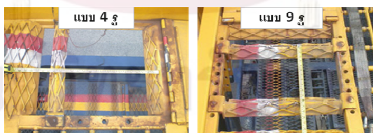
รูปที่ 4.16 แสดงมาตรฐานเครื่องห้ามล้อ (Stopper) ประเภทหลุม
