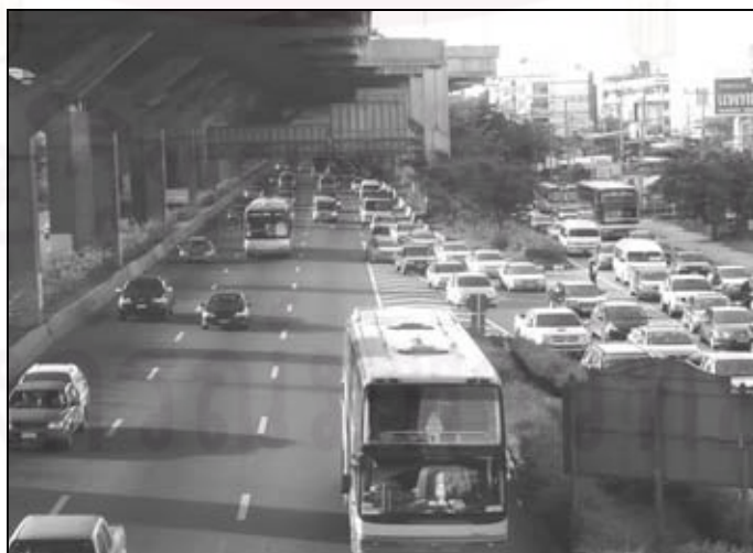
ภาพที่ 1.1 ภาพถ่ายคอขวดจราจรประเภททางแยกออก
