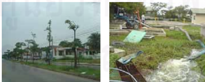
รูปที่ 4-6 แสดงถนนภายในโครงการและบ่อบำบัดน้ำเสีย
