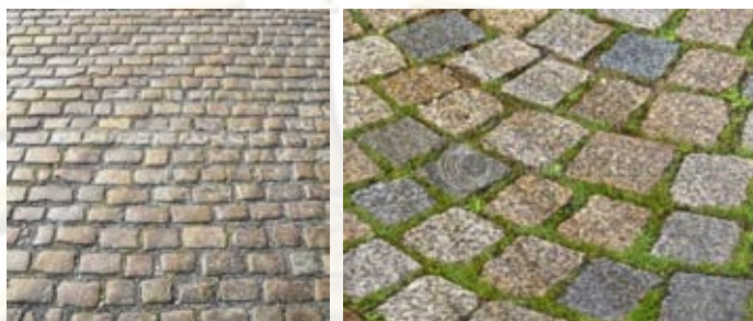
ภาพที่ 4.8 การใช้วัสดุปูพื้นเพื่อชะลอความเร็วของรถยนต์ที่จะเข้าสู่ถนนคนเดิน (ที่มา: shutterstock images, 2001: online)
