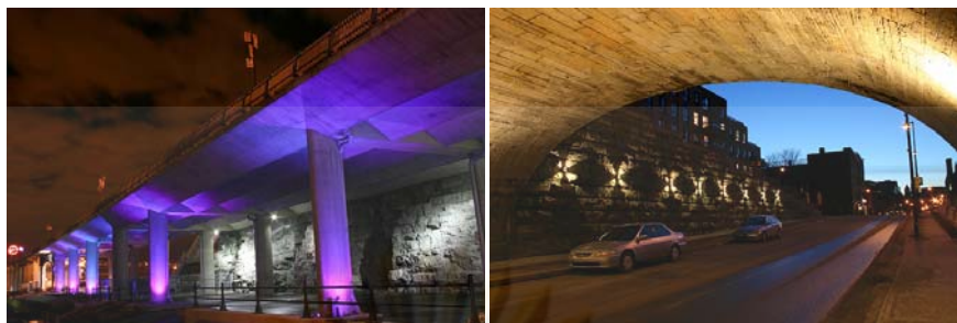
ภาพที่ 4.10 ตัวอย่างการให้แสงสว่างพื้นที่ใต้สะพาน เพื่อให้เกิดความปลอดภัยในการใช้งานพื้นที่ว่างสาธารณะบริเวณใต้สะพาน (ที่มา: Old Montreal, 2001: online)
