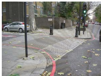
ภาพที่ 4.5 ตัวอย่างการยกกระดุมทางม้าลายให้เท่ากับระดับของทางเดินเท้า (Raised crosswalks)
