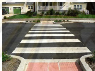
ภาพที่ 4.6 ตัวอย่างการยกกระดุมทางเดินเท้าให้เท่ากับระดับของทางม้าลาย
