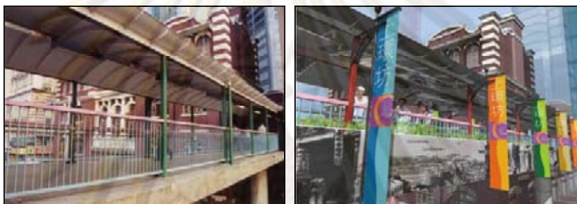
ภาพที่ 2.25 (ซ้าย) บริเวณสะพานก่อนการปรับปรุง (ขวา) บริเวณสะพานหลังการปรับปรุง
