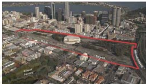
ภาพที่ 2.8 ที่ตั้งของโครงการเดอะลิงก์ (The Link Project) (ที่มา : East Perth Redevelopment Authority, 2008: online)
