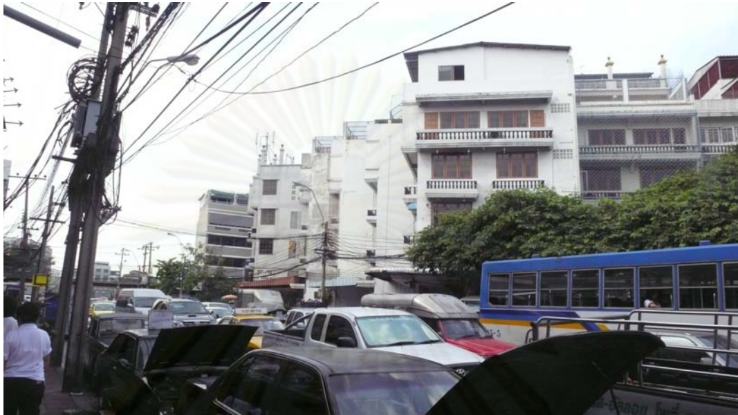
รูปที่ 4.20 พื้นที่บริเวณวัดดวงแข มุมมองจากถนนรองเมือง
