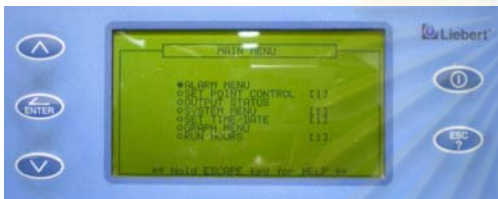
รูปที่ 2 งานตรวจสอบสัญญาณเตือนระบบทำความเย็น
