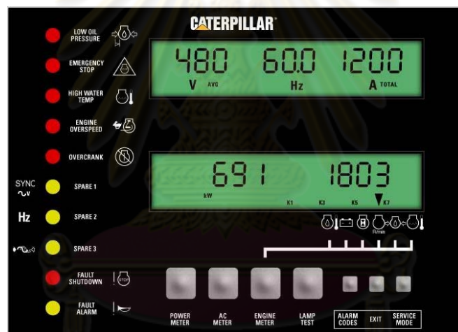
รูปที่ 2.11 ส่วนต่อประสานกับผู้ใช้เครื่องกำเนิดไฟฟ้า
