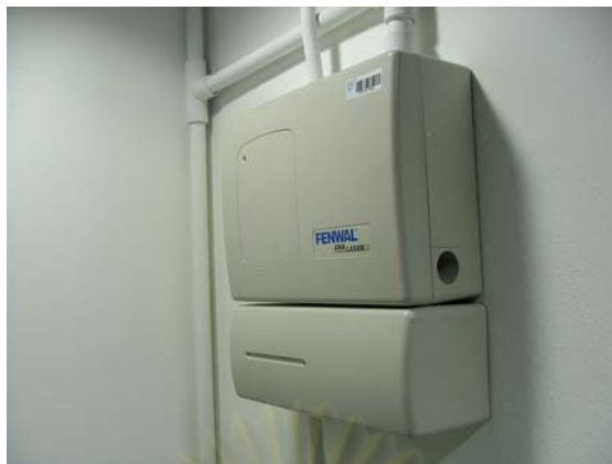
รูปที่ 2.6 ระบบตรวจจับความร้อนด้วยความไวสูง
