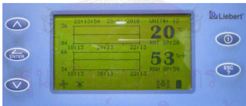
รูปที่ 2.5 ส่วนต่อประสานกับผู้ใช้เครื่องปรับอากาศแบบควบคุมความชื้น
