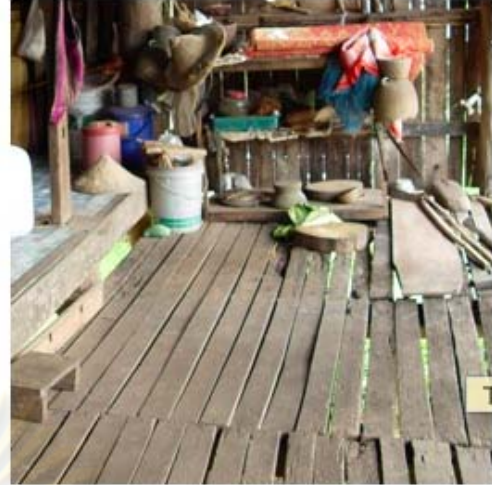
ภาพที่ 2.10 พื้นไม้จริงขนาด 8" X 1" และฝากไม้ไผ่ทาบ ขนาดประมาณ 8 นิ้ว X 1 นิ้ว
