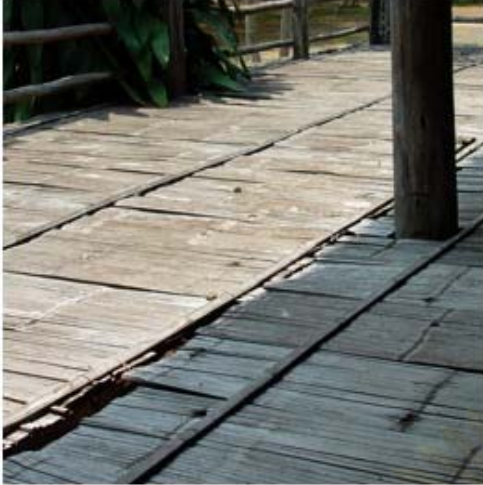
ภาพที่ 2.10 พื้นไม้จริงขนาด 8" X 1" และฝากไม้ไผ่ทาบ ขนาดประมาณ 8 นิ้ว X 1 นิ้ว
