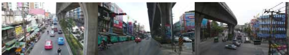
รูปที่ 4.28 สภาพถนนสุขุมวิท
