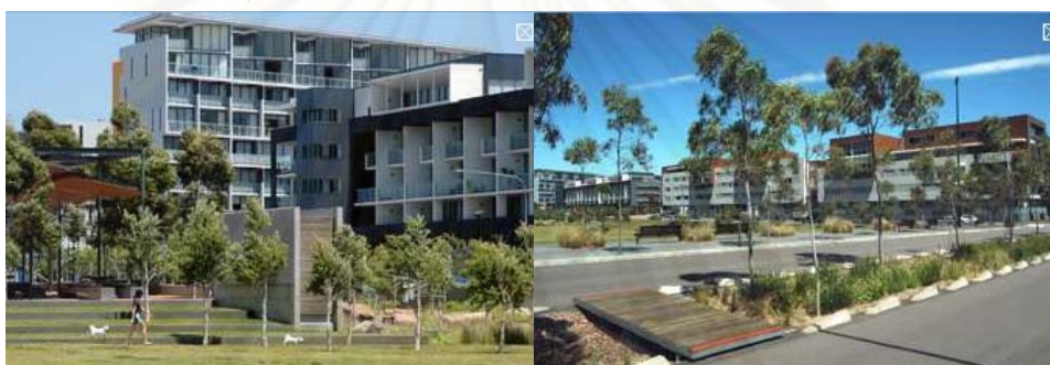
รูปที่ 2.30 กลุ่มอาคารพักอาศัยความสูงระดับกลาง โครงการ Victoria Park, Zetland (ที่มา : www.landcom.nsw.gov.au )
