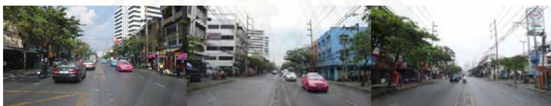
รูปที่ 4.30 สภาพถนนสุขุมวิท 71
