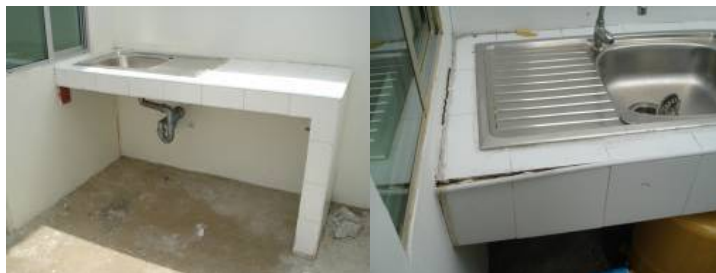
รูปที่ 4.7 ขอบบกร่องที่ก่อให้เกิดปัญหาและเป็นงานที่ต้องอาศัยทักษะฝีมือเป็นหลัก
