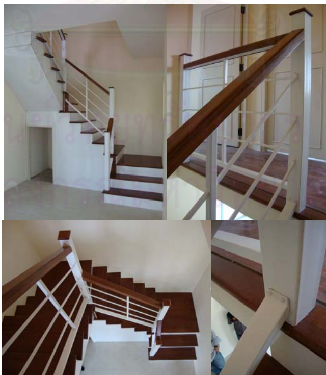
รูปที่ ค.9 ตัวอย่างงานราวบันไดใหม่ที่ใช้วัสดุหลักเป็นเหล็ก แล้วนำมาประกอบที่หน้างาน
