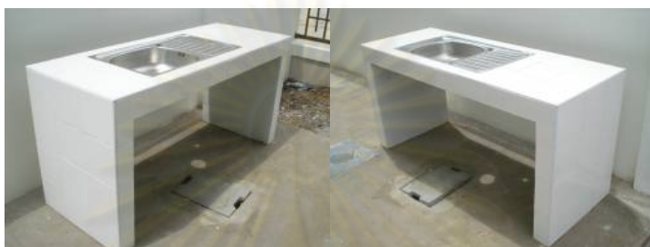
รูปที่ 4.8 เคาร์เตอร์ใหม่ที่ลดปัญหารอยแตกร้าวที่เกิดขึ้นและลดการใช้ทักษะฝีมือช่าง
