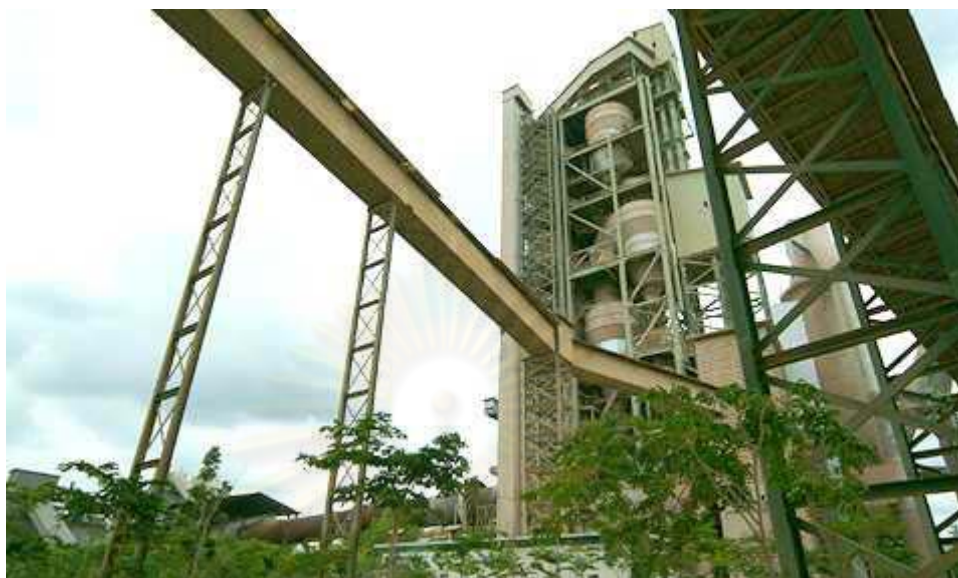
รูปที่ 3.7 หอดุ่น (Pre heater)
