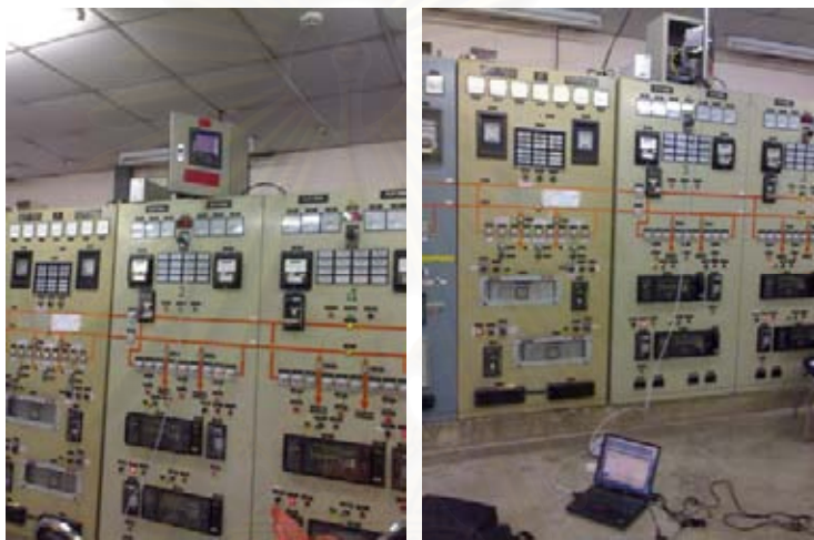
รูปที่ 5.1 การติดตั้งเครื่องวัดคุณภาพไฟฟ้าที่สถานีต้นทาง
