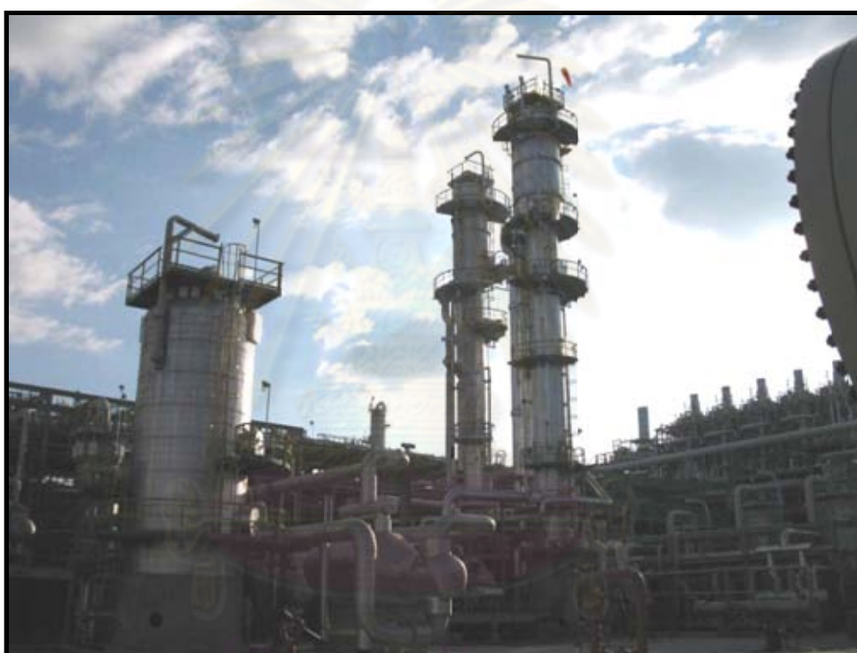
ภาพที่ 4.3 ระบบดีโพรพานไนเซอร์ความดันต่ำ (Low Pressure Depropanizer) และระบบเครื่องปฏิกรณ์ C3 ไฮโดรจิเนชั่น
