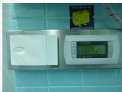
ภาพที่ 4.43 แสดง เครื่องอ่านอุณหภูมิและความชื้นสัมพัทธ์
