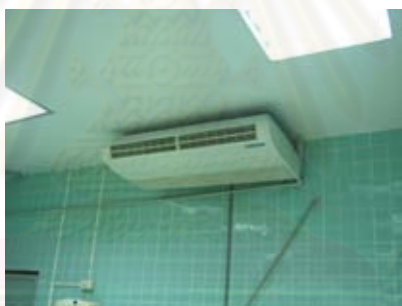
ภาพที่ 6.9 แสดง เครื่องปรับอากาศแบบ Split Type
