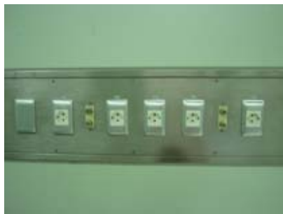
ภาพที่ 4.67 แสดง ปลั๊กไฟภายในห้องผ่าตัดกระดูก โรงพยาบาล C
