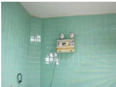
ภาพที่ 4.109 แสดง การลบมุมห้อง ภายในห้องผ่าตัดกระดูก
