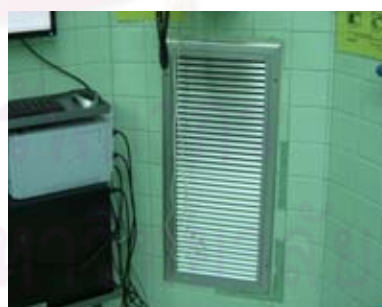
ภาพที่ 4.96 แสดง ช่องดูดอากาศกลับ (Return air)
