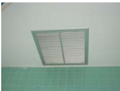
ภาพที่ 4.123 แสดง ช่องดูดอากาศกลับ
