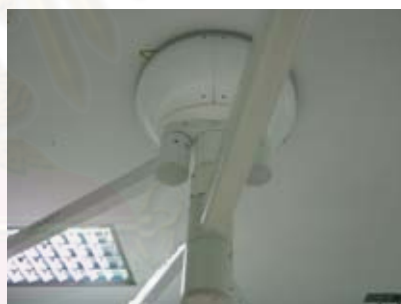
ภาพที่ 4.119 แสดง การติดตั้งโคมไฟผ่าตัดแบบแขวน
