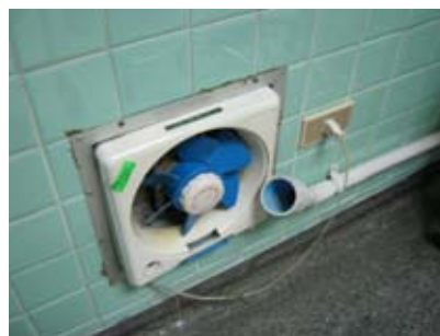
ภาพที่ 4.124 แสดง ช่องดูดอากาศทิ้ง
