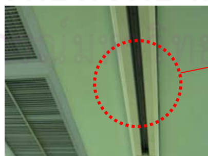
ภาพที่ 4.70 แสดง รางเลื่อนโคมไฟผ่าตัดกระดูก โรงพยาบาล C
