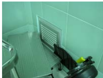
ภาพที่ 4.16 แสดง ช่องดูดอากาศทิ้ง (Exhaust)
