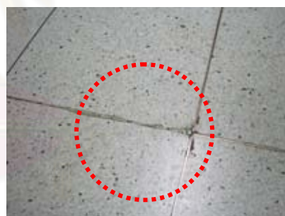
ภาพที่ 4.107 แสดง พื้นภายในห้องผ่าตัดกระดูก ภาพที่ 4.108 แสดง บริเวณแตกร้าวของ (Ortho1)โรงพยาบาลหาดใหญ่ กระเบื้องหินขัด
