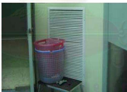
ภาพที่ 4.44 แสดง ช่องดูดอากาศกลับ (Return air)
