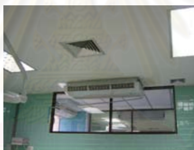
ภาพที่ 4.122 แสดง เครื่องปรับอากาศแบบ Split Type
