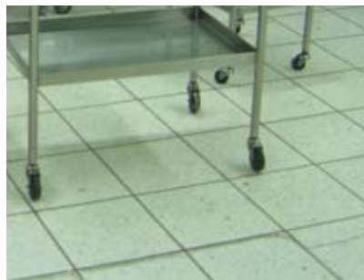
ภาพที่ 4.56 แสดง พื้นภายในห้องผ่าตัด ภาพที่ 4.57 แสดง ส่วนแตกร้างบริเวณเส้นทองเหลือง กระดุกโรงพยาบาล C
