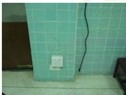
ภาพที่ 6.6 แสดง ตำแหน่งความสูงของปลั๊กไฟ
