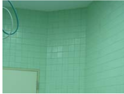
ภาพที่ 4.84 แสดง การลบมุมห้อง ภายในห้องผ่าตัดกระดูก
