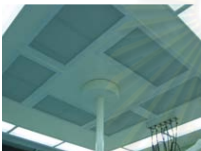
ภาพที่ 4.42 แสดง กรองอากาศด้วย Hepa filter
