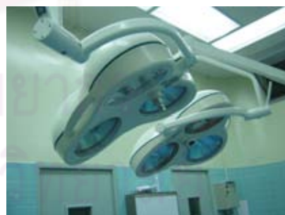
ภาพที่ 4.41 แสดง โคมไฟผ่าตัดภายในห้องผ่าตัดกระดูกโรงพยาบาล B
