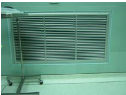
ภาพที่ 4.15 แสดง ช่องดูดอากาศกลับ (Return air)
