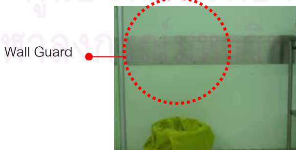
ภาพที่ 4.60 แสดง แผ่น Wall Guard กันกระแทกบริเวณเหลี่ยมผนัง ภายในห้องผ่าตัดกระดุกโรงพยาบาล C
