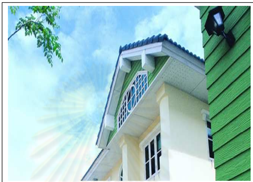
รูปที่ 1-3: การใช้ไฟเบอร์ซีเมนต์ในการก่อสร้างที่อยู่อาศัย
