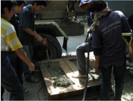
รูปที่ 3.16 การจี้คอนกรีต
