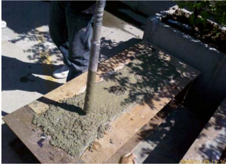
รูปที่ 3.43 การจี้คอนกรีต
