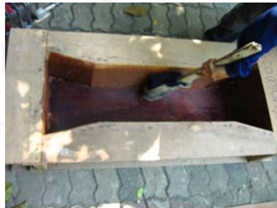
รูปที่ 3.11 การทาน้ำมันแบบไม้
