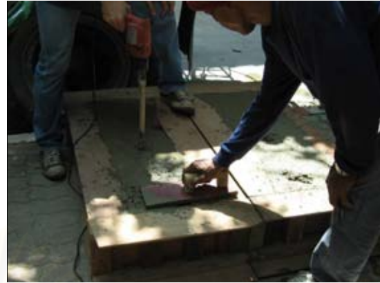
รูปที่ 3.17 การฉาบผิวคอนกรีต
