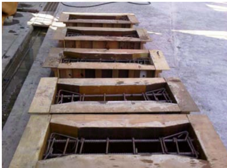
รูปที่ 3.39 แบบไม้สำหรับหล่อตัวอย่างเสาคอนกรีตเสริมเหล็ก
