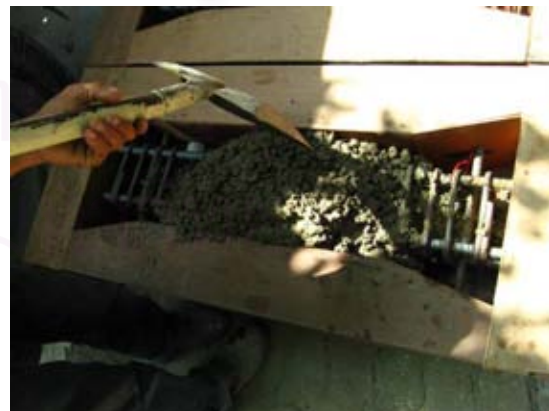
รูปที่ 3.15 พลั่วในการเทคอนกรีต
