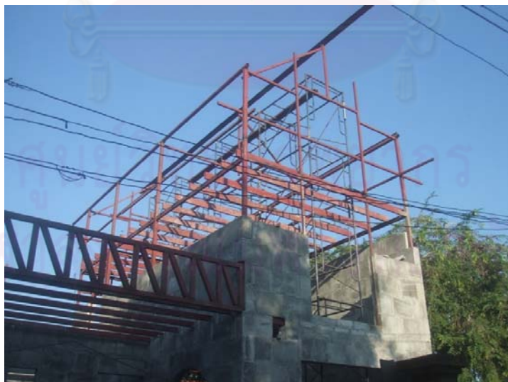
ภาพที่ 4-17 แสดงการเตรียมโครงสร้างหลังคา
