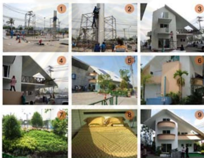
ภาพที่ 4-1 แสดงขั้นตอนการก่อสร้างบ้านพอเพียง World Alternative Energy Sciences Expo 2009
