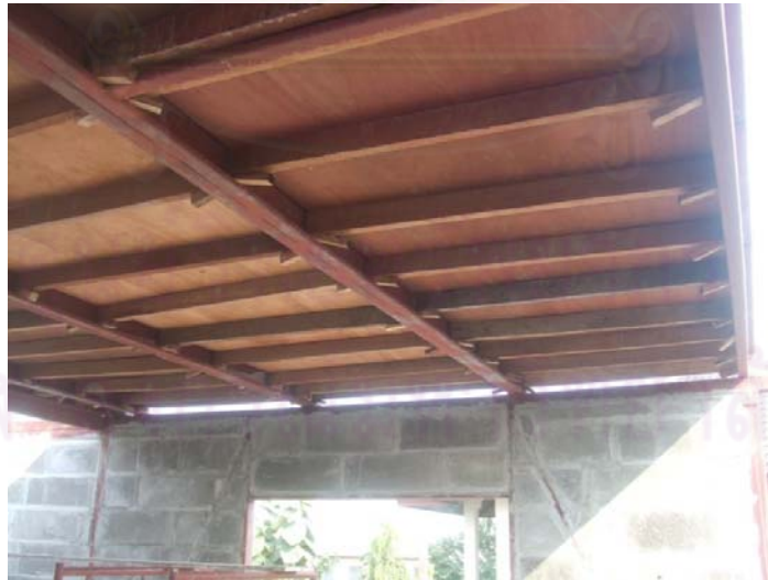
ภาพที่ 4-15 แสดงการติดตั้งแบบก่อนเทพื้นชั้น 2
