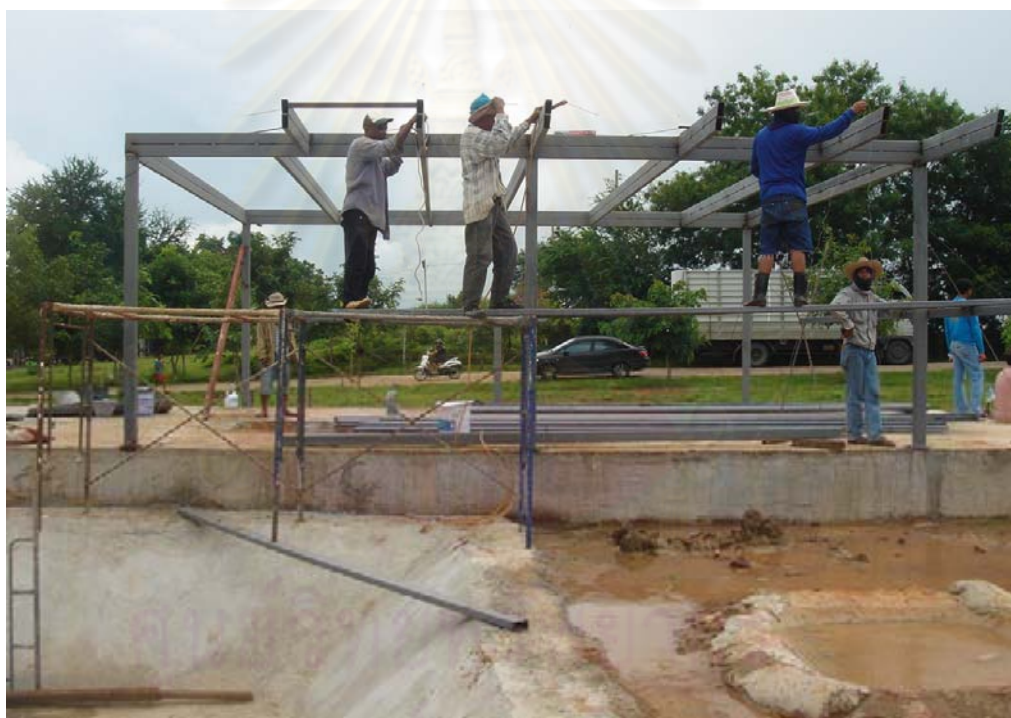
ภาพที่ 4-20 การขึ้นโครงสร้างพื้นชั้น 2 ของส่วนอาคารหลักด้วยโครงสร้างเหล็ก
