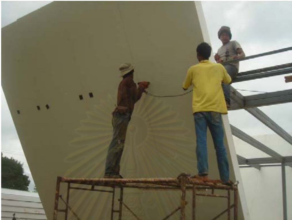
ภาพที่ 4-26 ติดตั้งผนังกับโครงสร้างพื้น
