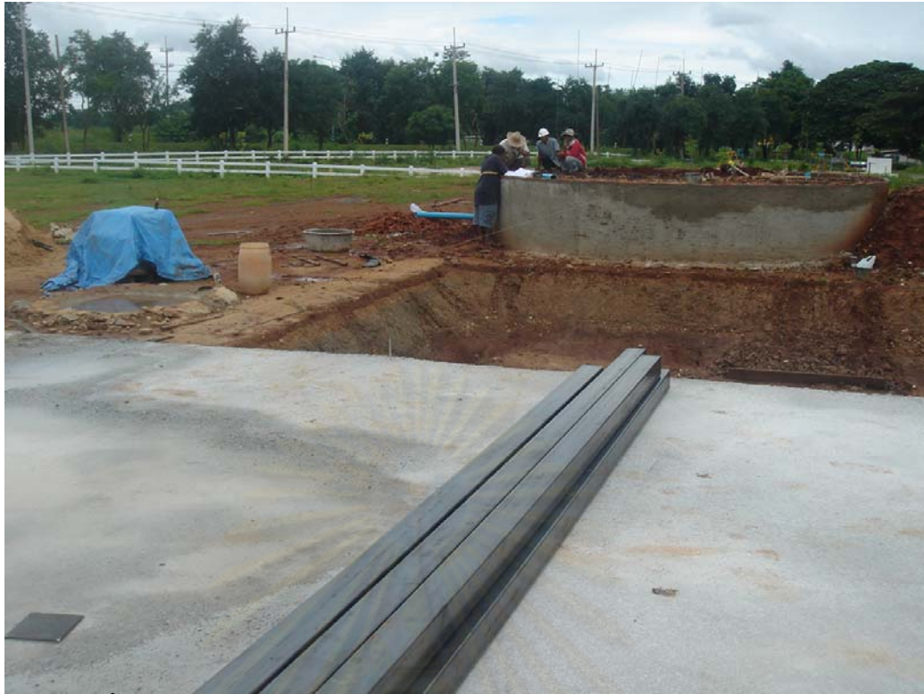
ภาพที่ 4-18 ชั้นฐานอาคาร ตามเทคนิคที่กำหนดเอาไว้ตามแบบ
