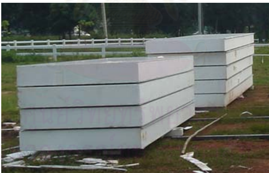
ภาพที่ 5 -14 แสดงแผ่นฉนวนสำเร็จรูปหนา 8” ตัดขนาดให้พอดีจากโรงงาน พร้อมติดตั้งทันที
