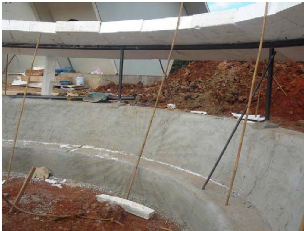
ภาพที่ 4-32 การใช้ประโยชน์จากดินโดนการขุดดินลงไปเล็กน้อย ตกแต่งเป็นชั้น วาง wire mesh ฉาบปูน เกิดเป็นอีก 1 ห้องที่จะสามารถทำงานได้ดี ประหยัดงบประมาณ แข็งแรง เย็นสบาย ได้รับอิทธิพลความเย็นจากดิน
