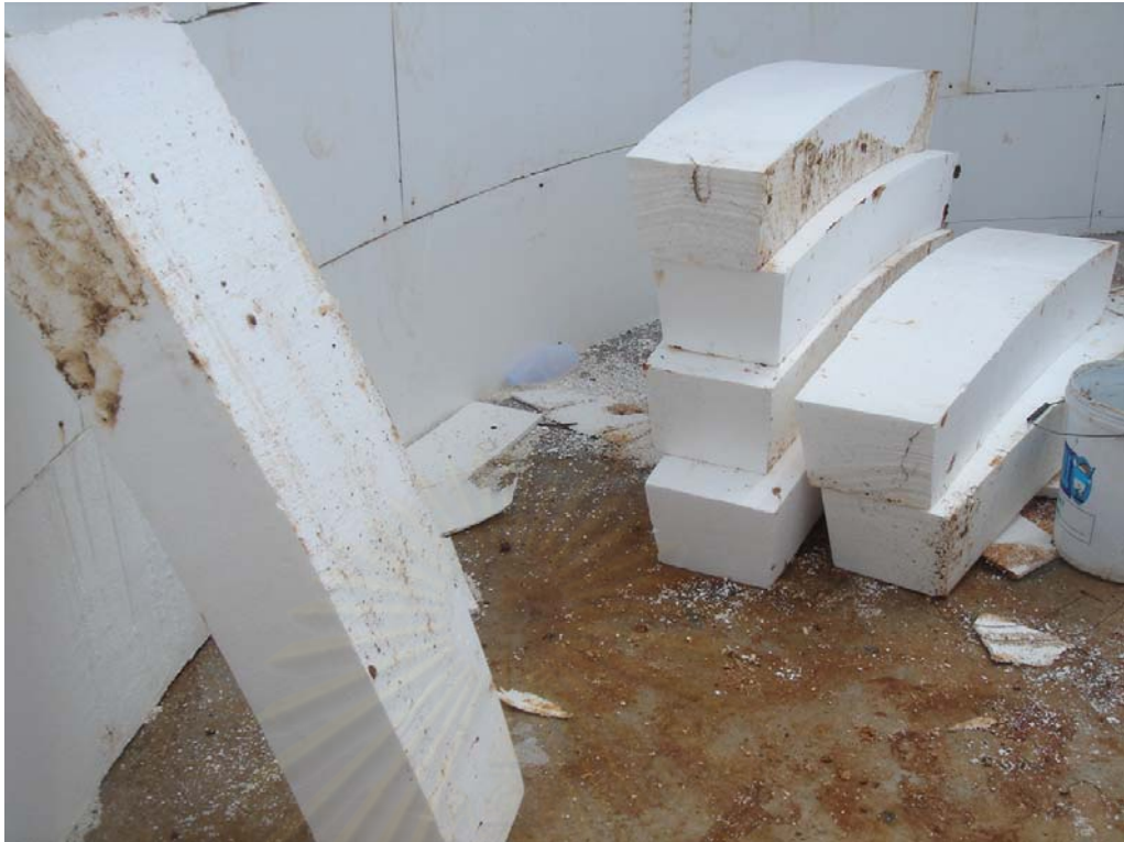
ภาพที่ 4-22 ส่วนประกอบ ที่ตัดมาเป็นชิ้นตามขนาด นำมาติดตั้งหน้างานได้ทันที
