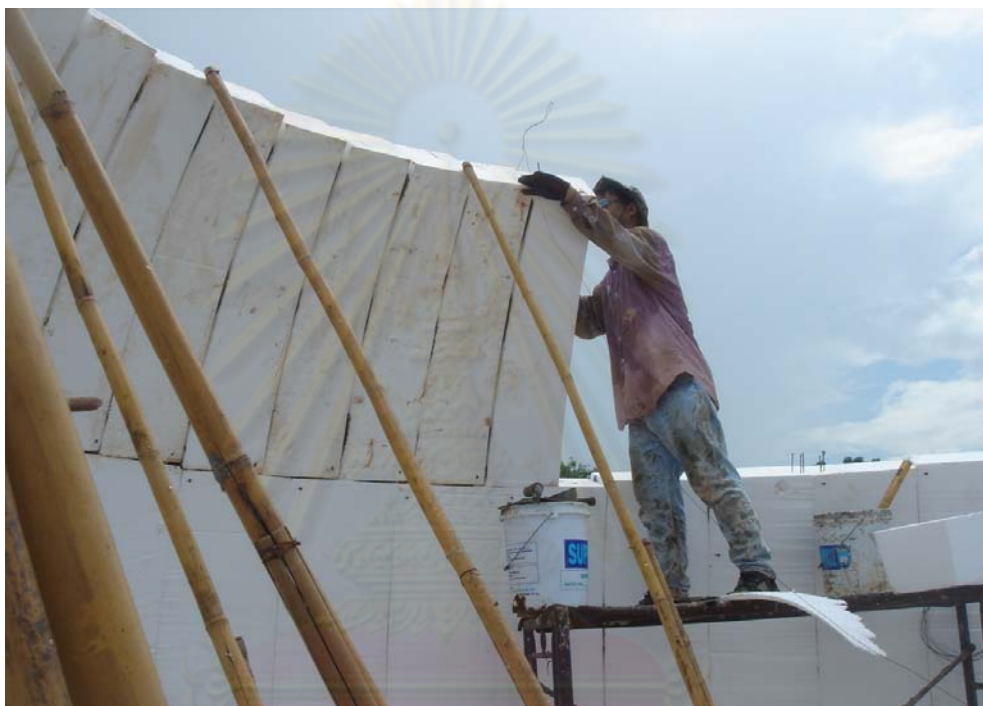
ภาพที่ 4-21 การขึ้นผนังของอาคารทรงครึ่งวงกลม (ห้องน้ำหญิง)
