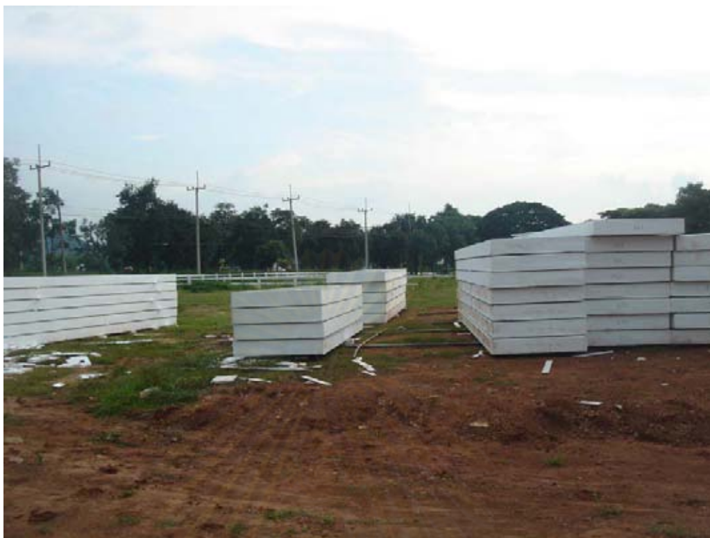
ภาพที่ 4-24 แผ่นฉนวนสำเร็จรูป หนา 8 นิ้ว วางแยกตามขนาดต่างๆ เตรียมติดตั้ง
