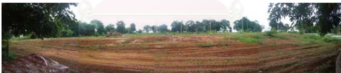
ภาพที่ 4-17 สภาพหลังจากปรับหน้าดินแล้ว (วันที่ 13 สิงหาคม 2553)
