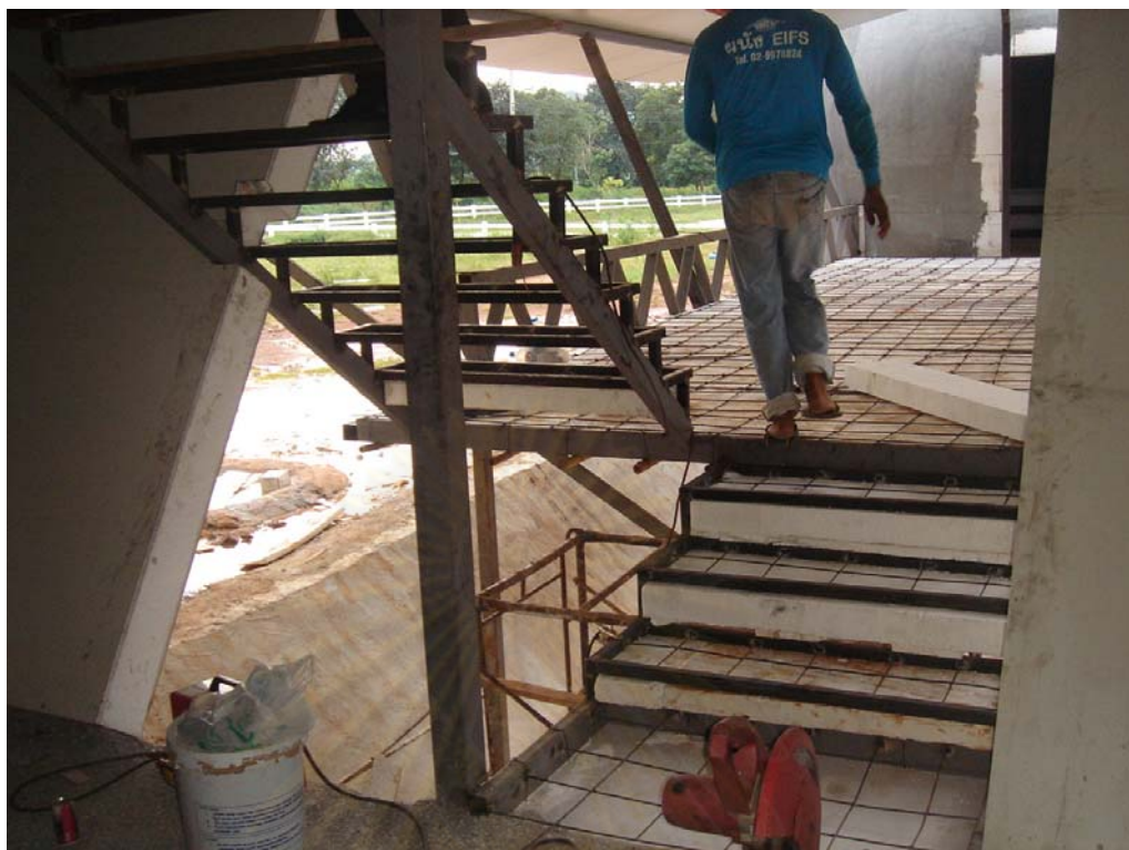
ภาพที่ 4-30 ใช้โครงสร้างพื้นเหล็ก Truss พาดพื้นเป็นโครงสร้างเหล็ก
