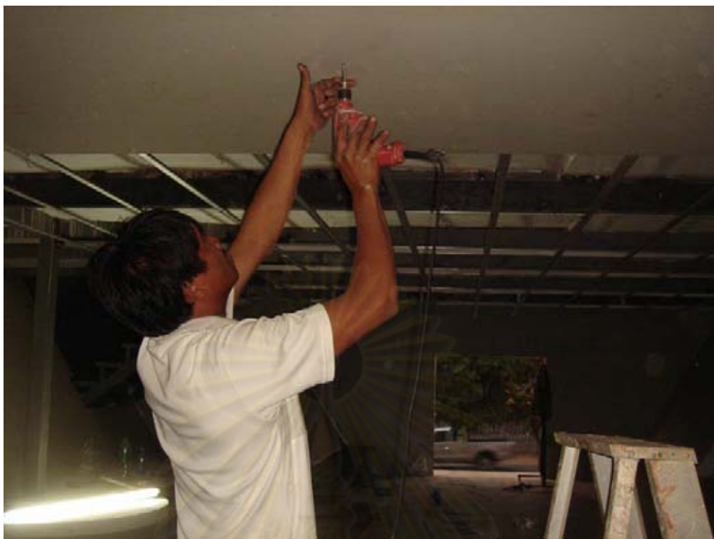
ภาพที่ 4-34 ติดตั้งฝ้าเพดาน
