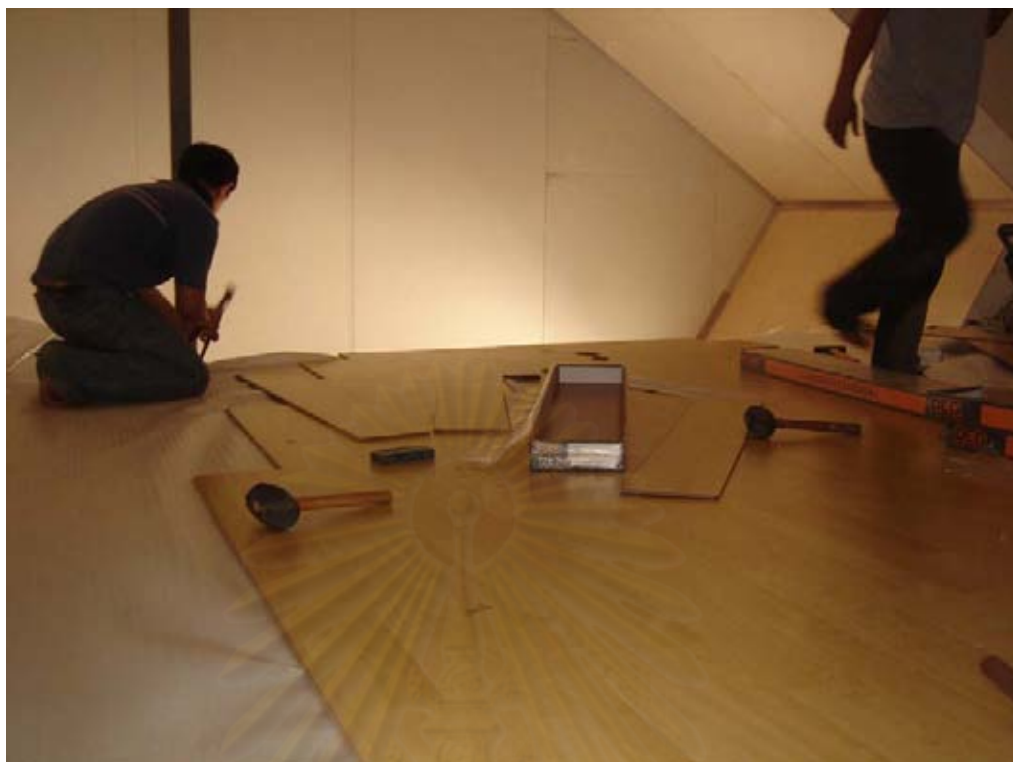
ภาพที่ 4-38 พื้นชั้น 2 ปูด้วยแผ่นไม้ลามิเนต ติดตั้งเร็ว สวยงาม ความสะดวกสบาย
