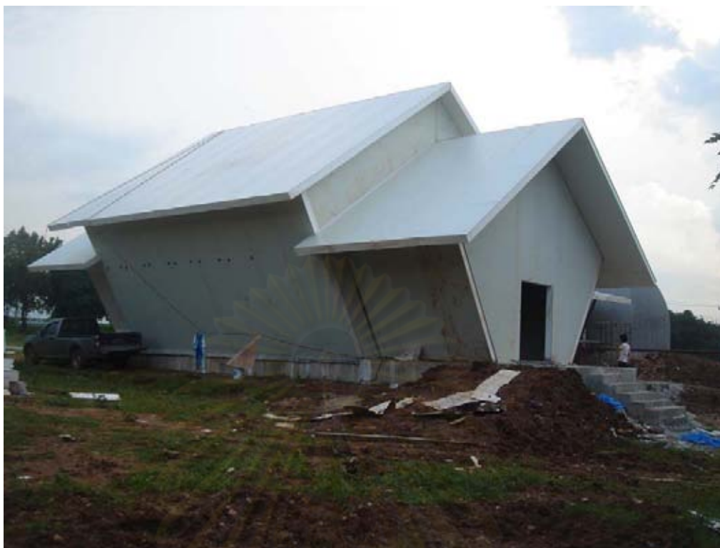
ภาพที่ 4-28 การติดตั้งแผ่นฉนวนสำเร็จรูปของอาคารหลัก โดยใช้เวลาติดตั้ง 5 วันเท่านั้น (คนงาน 7-8 คน)
