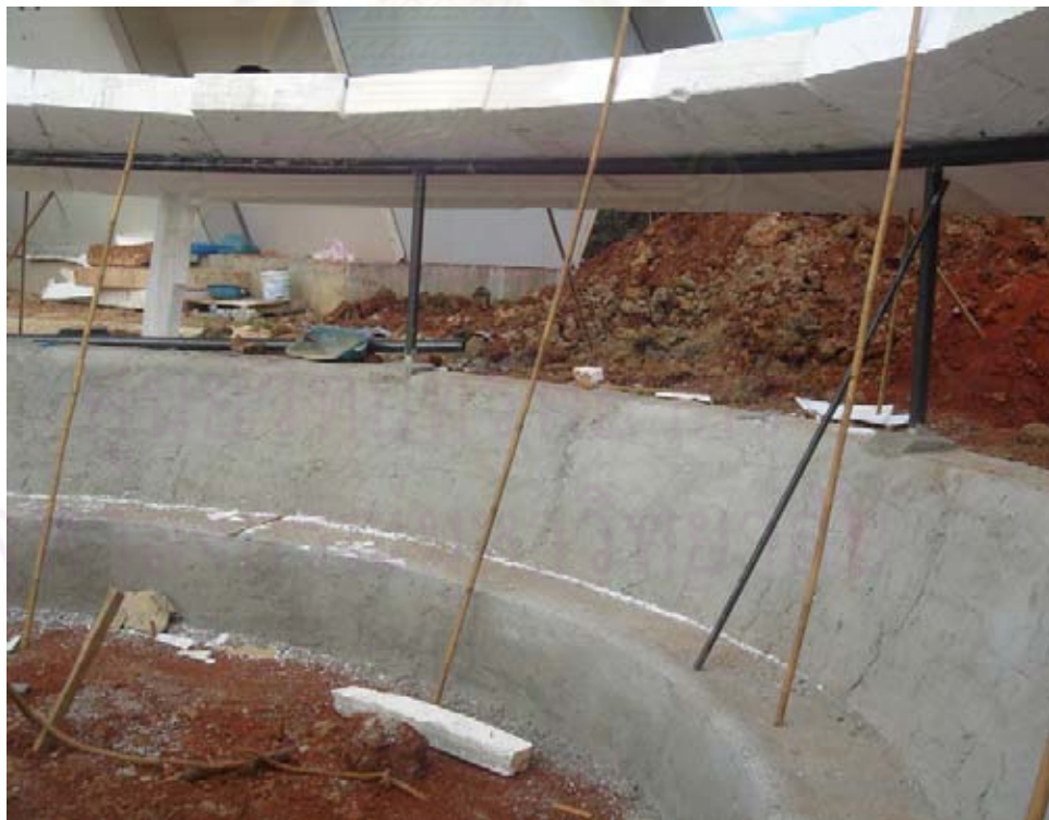
ภาพที่ 5 - 20 แสดงขุดดินและตักแต่งให้กลายเป็นแก๊วอี้ และได้รับความเย็นจากดินผ่าน ผนัง
