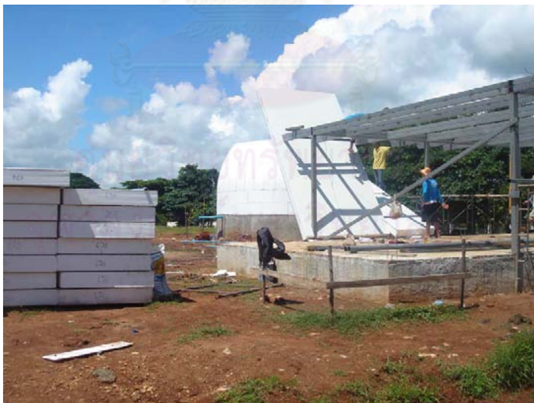
ภาพที่ 4-25 เริ่มการติดตั้งแผ่นฉนวนสำเร็จรูปใส่โพนที่ผนังอาคารหลักก่อนอื่น โดยแต่ละแผ่นจะสั่งมาขนาดที่พอดี โดยจะให้มีการตัดเหลือเศษน้อยที่สุด
