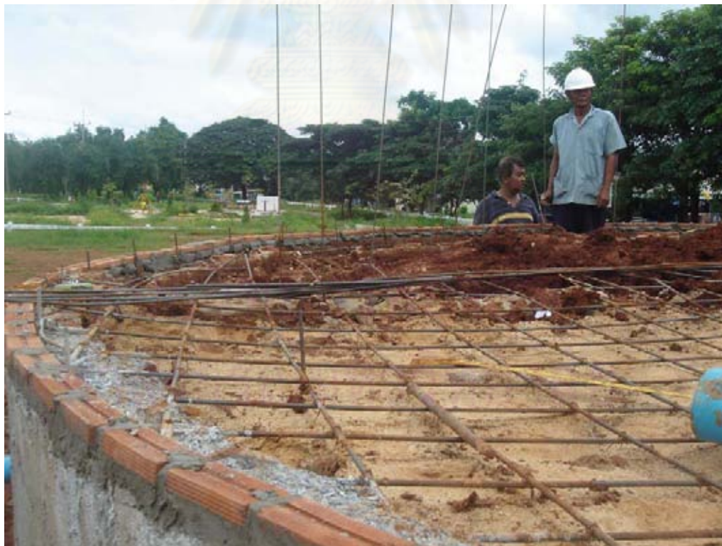
ภาพที่ 4-19 ชั้นฐานอาคาร ตามเทคนิคที่กำหนดเอาไว้ตามแบบ
