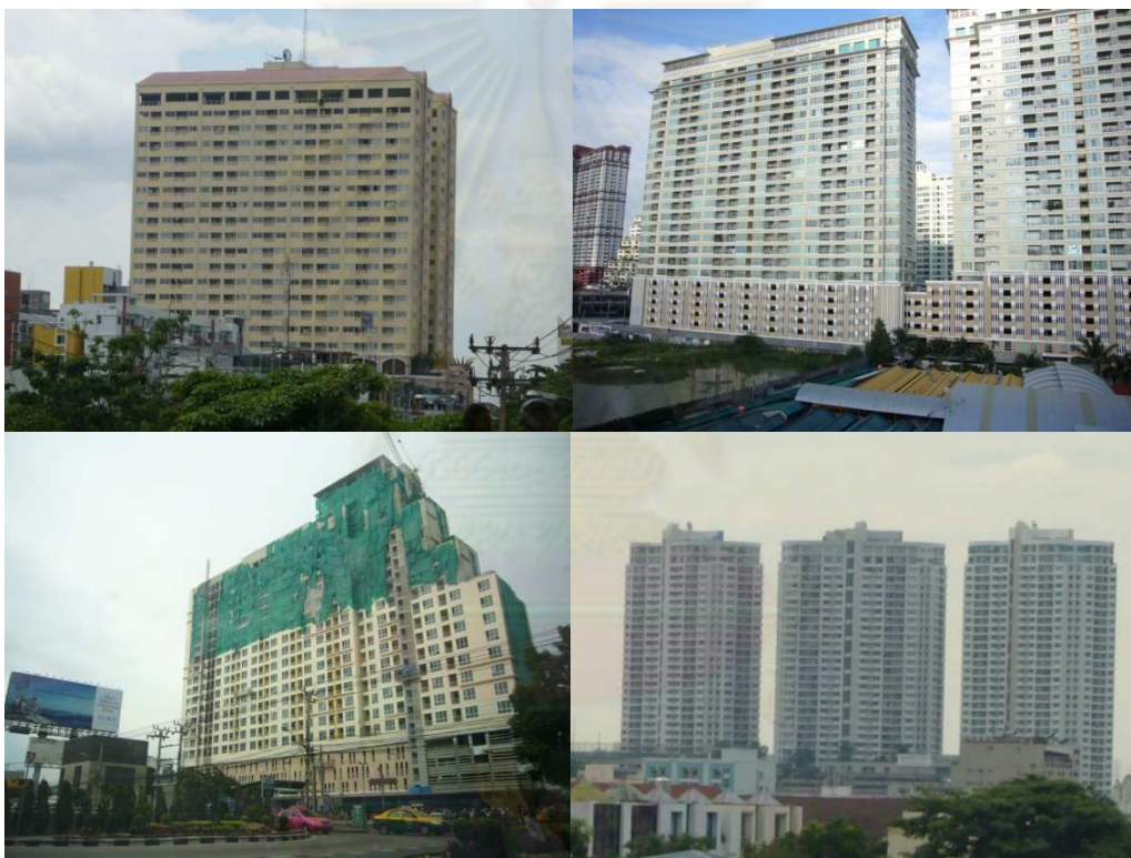
รูปที่ 3.1 อาคารที่ผังแบบตัวไอ (I)
