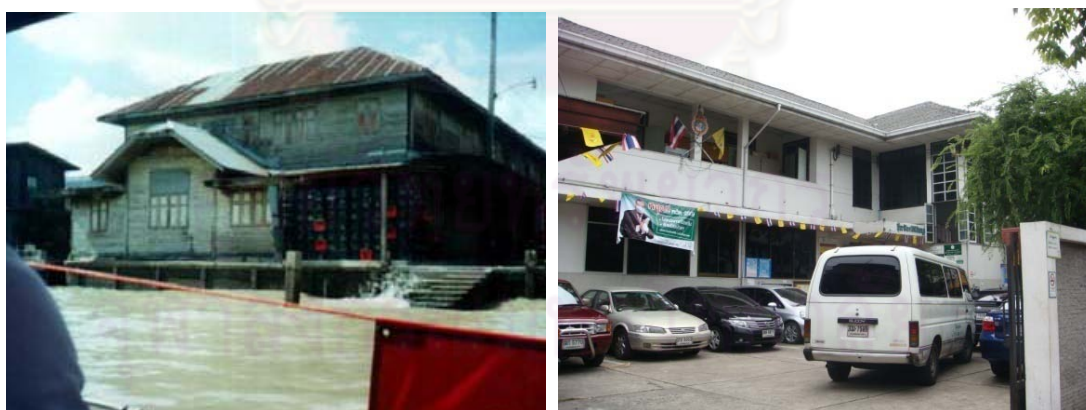
ภาพ 6.7 อาคารที่ทำการไปรษณีย์ตลาดพลู คือโกดังร้านแฮ้เด็กเซ็ง (ซ้าย) และสถานีอนามัยจันทรมิพญูลย์ในปัจจุบัน (ขวา) (ที่มา: พวงร้อย กล่อมเอียง และคณะ, 2547 และ โดยผู้วิจัย, 2552)
