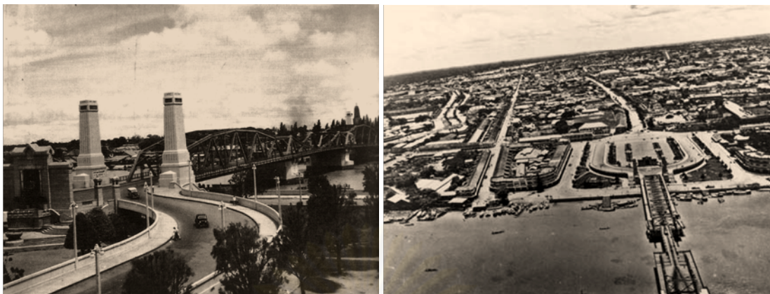
ภาพ 4.6 ภาพถ่ายทางอากาศการสร้างสะพานพุทธ พ.ศ.2474 เชื่อมฝั่งธนบุรีและฝั่งพระนคร (ซ้าย) และสะพานพุทธ ถ่ายจากฝั่งพระนคร (ขวา) (ที่มา: หอจดหมายเหตุแห่งชาติ)
