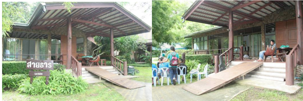
ภาพที่ 5.77 - 5.78 บ้านพักเยาวชนที่มีการจัดทำทางลาดสำหรับเยาวชนที่ต้องใช้รถวีลแชร์
