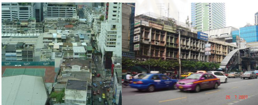
ภาพที่ 4.5 อาคารพาณิชย์ใหม่
