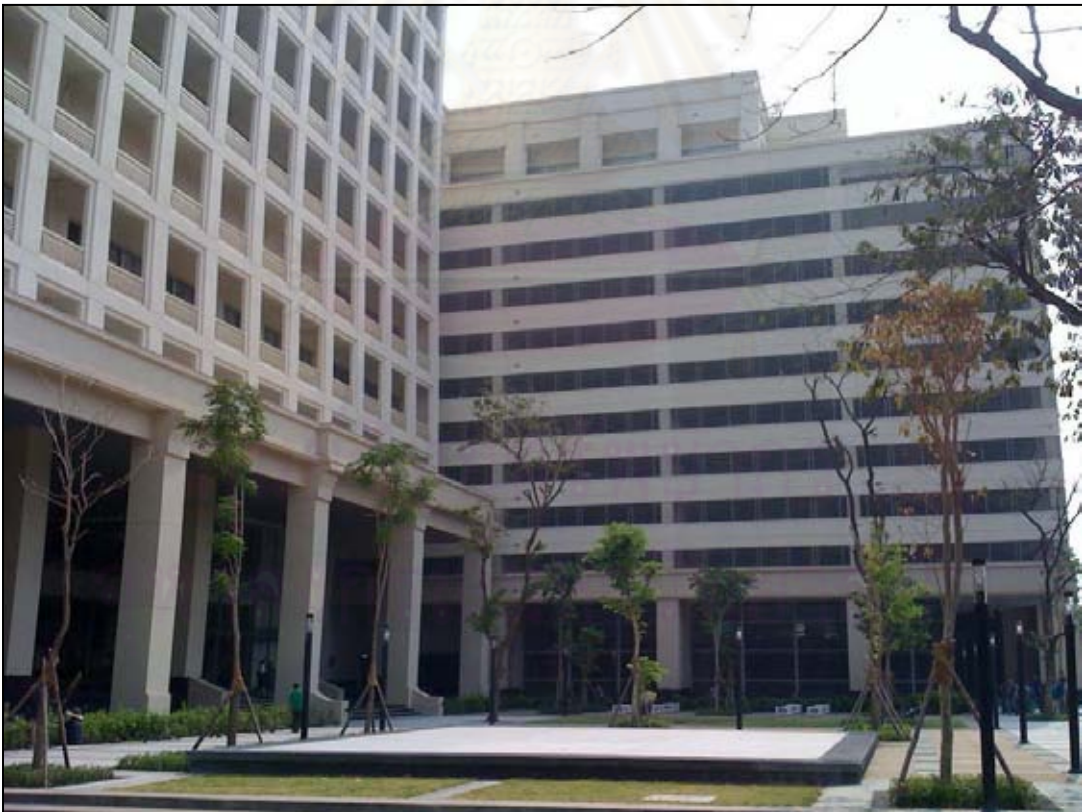
รูปที่ 4.1 อาคารมหาจักรีสิรินธรและอาคารจอดรถที่ติดกับอาคารมหาจักรีสิรินธร
