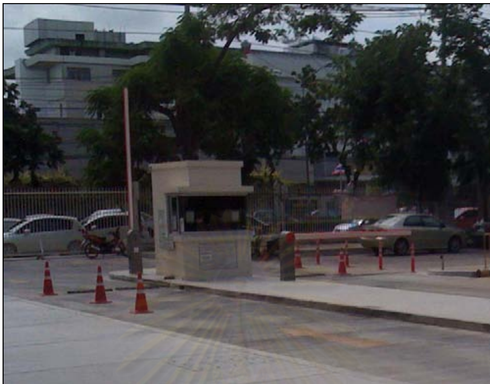
รูปที่ 4.4 บริเวณทางเข้าและออกอาคารจอดรถที่ติดกับอาคารมหาจักรีสิรินธร
