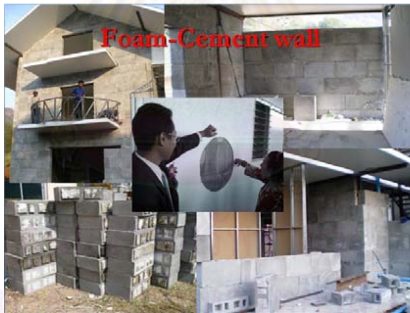
ภาพที่ 2-4 วัสดุในก่อสร้างบ้านพอเพียง
