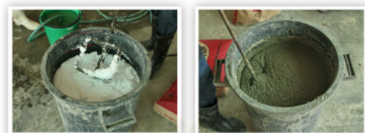
ภาพที่ 11 ขั้นตอนการผสมด้วยมือหรือใช้สว่านผสม (ที่มา: http://www.cebau.com )
