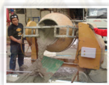
ภาพที่ 12 การผสมด้วยเครื่องไม่ปูน (ที่มา: http://www.cebau.com )
